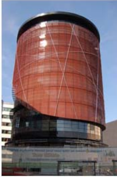
Figure : La tour Elithis est recouverte d'un treillis métallique pour la protéger des ardeurs du soleil estival.
