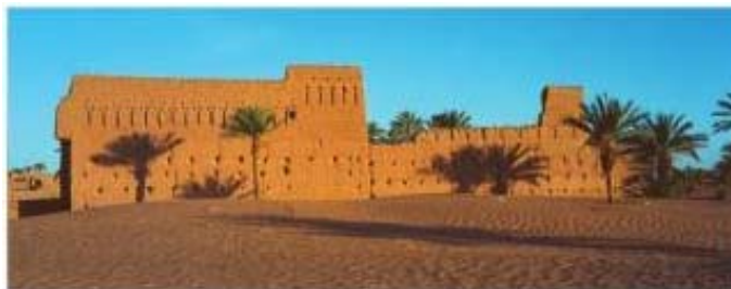
Figure 53: La plus ancienne casbah en terre battue de la vallée de Draa au Maroc (photo A .Sbai)
