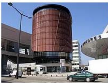
Figure : Le volume rouge enveloppant la façade la plus exposée est en fait un « bouclier thermique » amenuisant naturellement le rayonnement solaire à l'intérieur.
