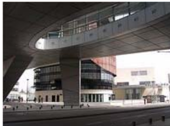
Figure : Structure poteaux-poutres mixte bois / acier, parement en tôle d'aluminium à l'extérieur Photos : François Lombard
