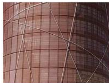
Figure : Le volume rouge enveloppant la façade la plus exposée est en fait un « bouclier thermique » amenuisant naturellement le rayonnement solaire à l'intérieur.
