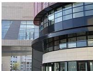
Figure : menuiseries extérieures seront composées d'un double vitrage argon à isolation thermique Photos : François Lombard
