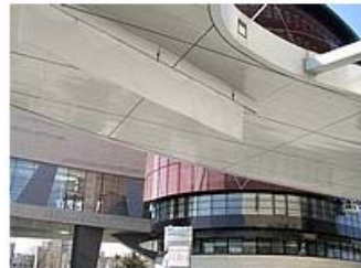
Figure : Structure poteaux-poutres mixte bois / acier, parement en tôle d'aluminium à l'extérieur Photos : François Lombard
