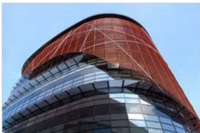
Figure : Le volume rouge enveloppant la façade la plus exposée est en fait un « bouclier thermique » amenuisant naturellement le rayonnement solaire à l'intérieur.
