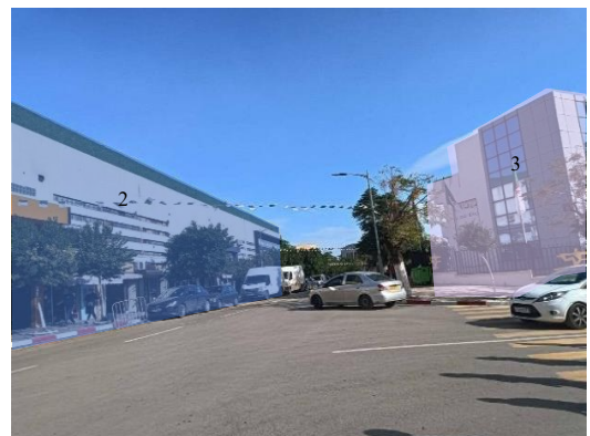
Figure 114 : Vue sur le nœud de la maison de la culture, (source : auteur, 2024).
