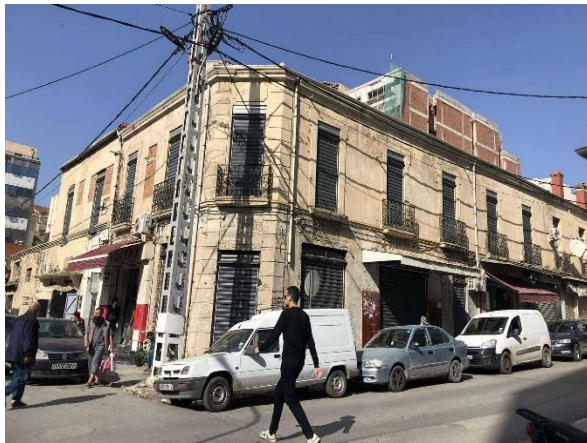
Figure 243 : Vue sur le bâtiment d'angle avant l'intervention, (source : auteur).
