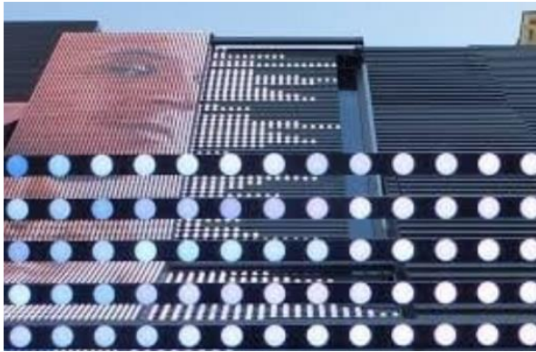
Figure 294 : LED sur le débordement du porche d'entrée, (source : archdaily).
