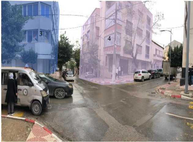
Figure 39 : Vue sur l'intersection de la Cinémathèque, (source : auteur, 2024).
