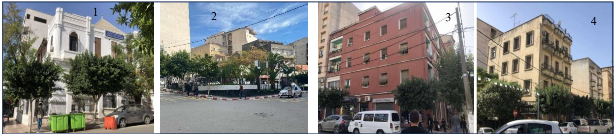
Figure 117 : Vue sur les différentes parois de l'intersection du monument, (source : auteur, 2024).
