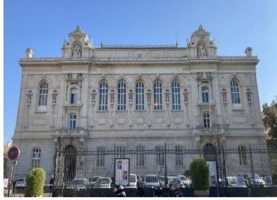
Figure 201 : Conservatoire à Rayonnement Régional.
