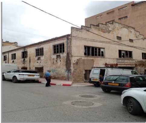
Figure 163 : Ancien dépôt des produits alimentaires, (source : auteurs, 2024).
