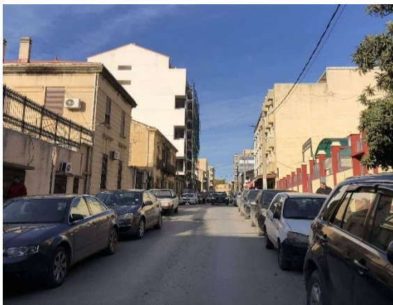
Figure 252 : Vue sur la rue Oubouzar Cherif avant l'intervention, (source : auteur).
