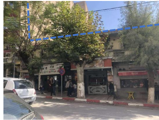
Figure 70 : Vue sur la façade droite de Bd Med Said Ouzeffoun, (source : auteur, 2024).
