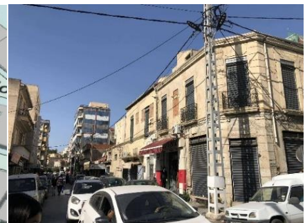
Figure 137 : Vue sur la façade Oubouzar Cherif, (source : auteurs, 2024).
