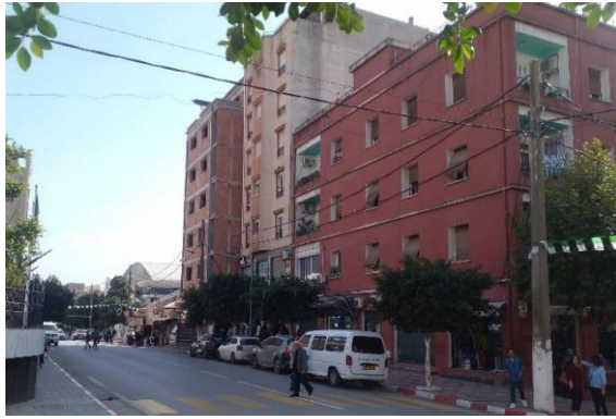
Figure 237 : Vue sur les bâtiments avant l'intervention, (source : auteur).
