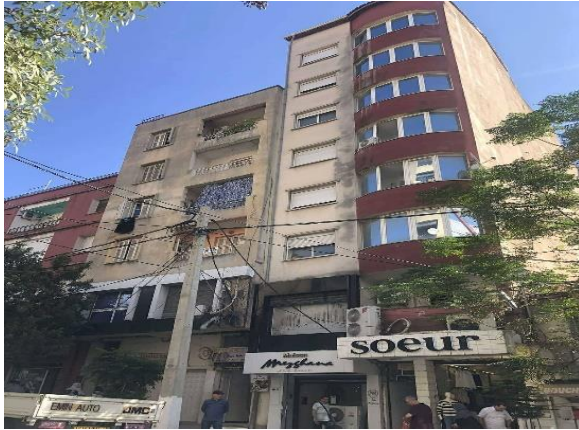
Figure 246 : Vue sur les bâtiments avant l'intervention, (source : auteur).
