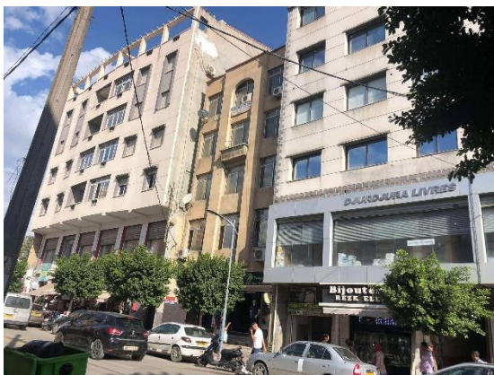
Figure 231 : Vue sur les bâtiments avant l'intervention, (source : auteur).
