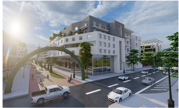
Figure 238 : Vue sur les bâtiments après l'intervention, (source : auteur).
