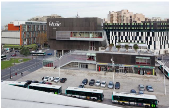
Figure 299 : Vue sur le parvis des lilas, (source : archdaily).
