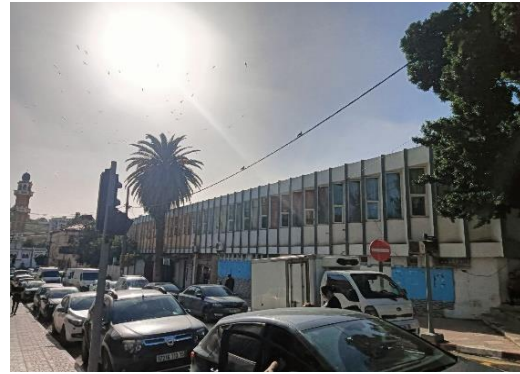
Figure 65 : Vue sur la façade gauche de Bd Iheddaden, (source : traité par auteur, 2024).
