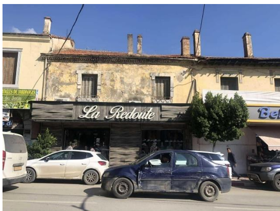
Figure 142 : Vue bâtiment colonial avec commerce, (source : auteurs ,2024).
