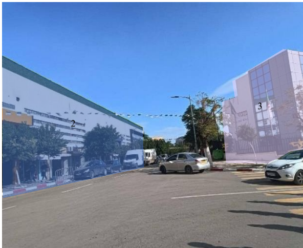
Figure 14 : Vue sur le nœud de la maison de la culture, (source : auteur, 2024).
