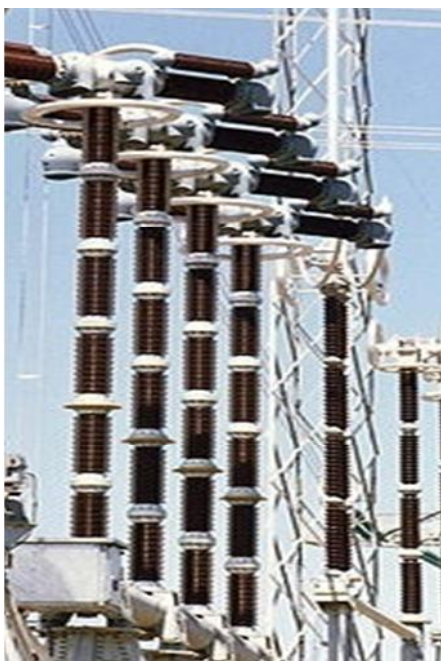
FigureIII.6 : Disjoncteur à air comprimé
