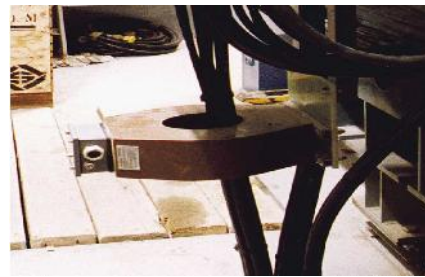
Figure III.11 Transformateur de courant type tore.
