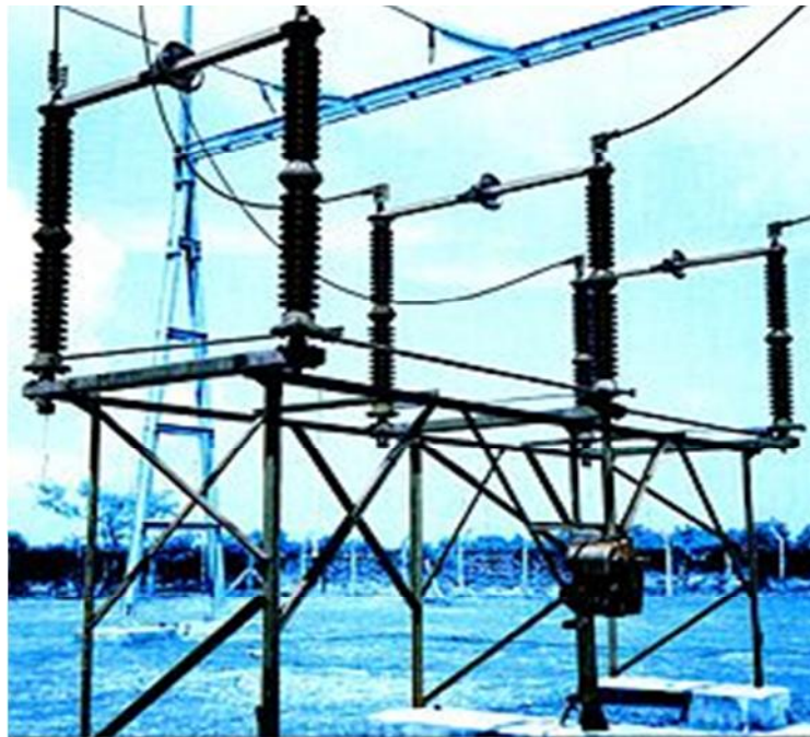
Figure III.7 Sectionneur moyenne tension
