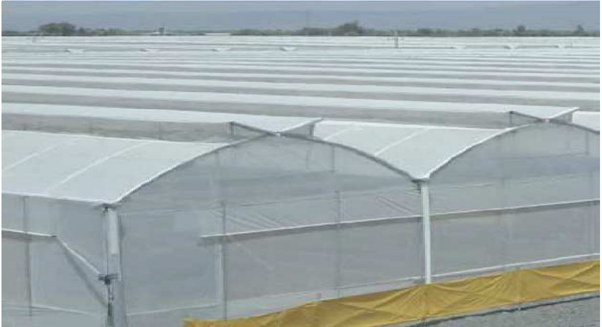
Figure I.2. Une serre multi-chapelle [8].
