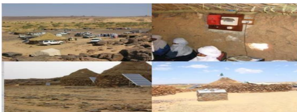
Figure 2.12 : Générateur photovoltaïque installé à Djanet willaya d'Illizi
