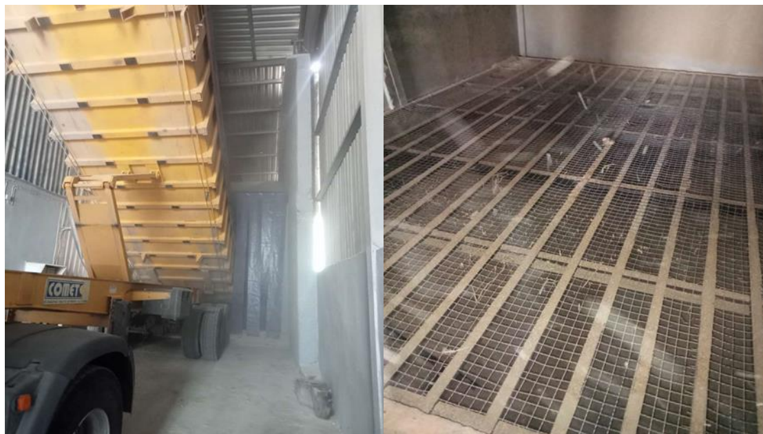
Figure 13 : déchargement du blé réceptionné du camion à la trémie de réception
