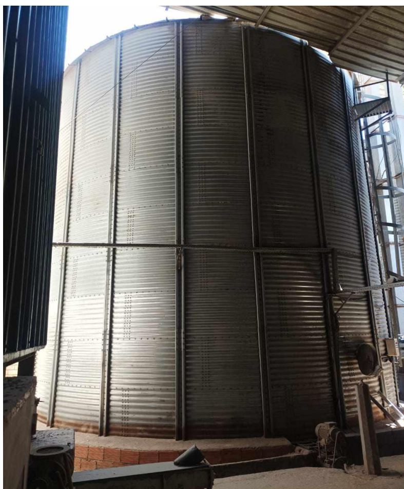
Figure 16 : silo de stockage pour le blé réceptionné
