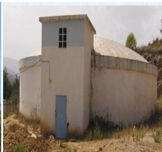
Figure 4.2 : Réservoir posé au sol
