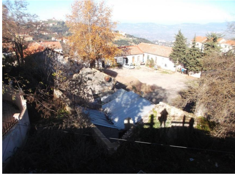
Figure : Le magasin des subsistances vu depuis la place Abane Ramdane
