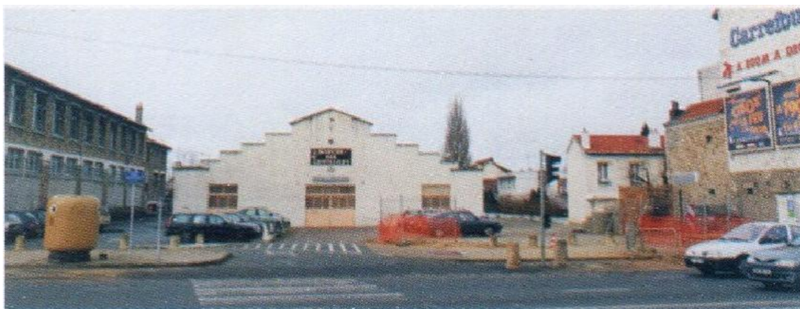
Figure : Ancienne halle démolie
