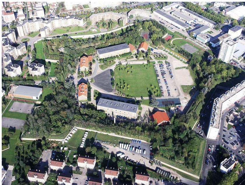
Figure: Ouvrage sur un point stratégique
