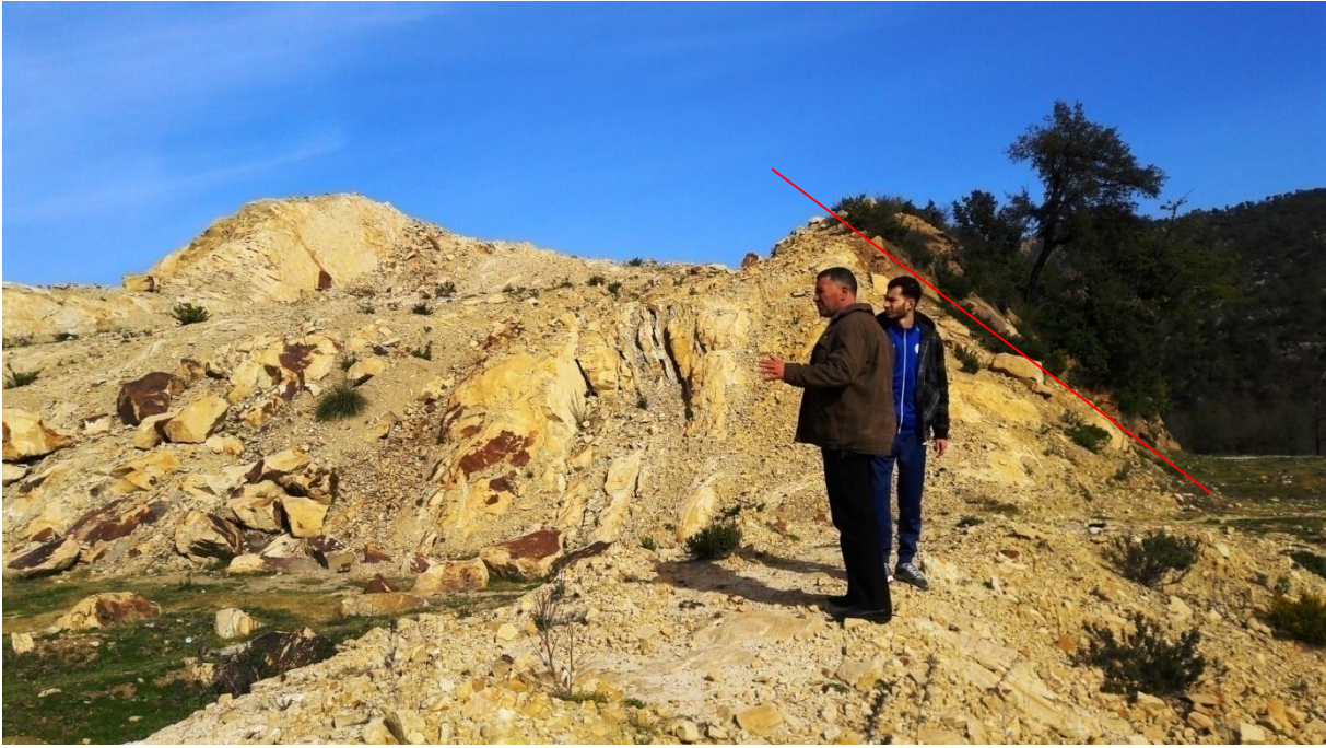
Figure 36. Vue de coté de la partie non impactée par les travaux d'exploitation.
