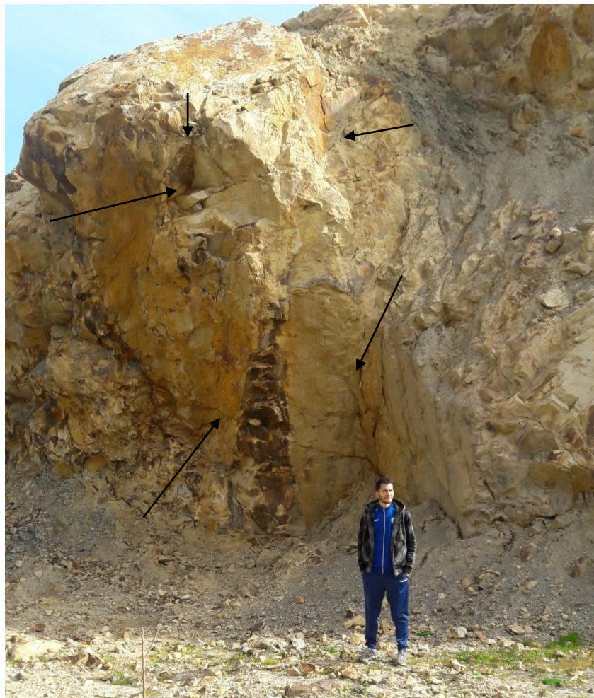
Figure 27. Vue de l'écaille horizontale désolidarisée.
