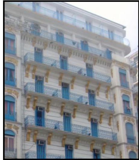
Figure : façade d'un immeuble coloniale Source : auteur
