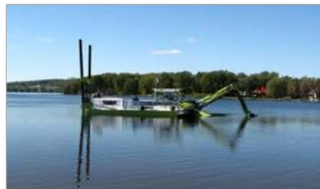
Travaux de dragage
