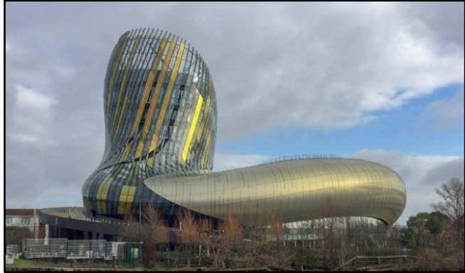
Figure 8 : : la cité du Vin à Bordeaux Source : https://www.la-croix.com
