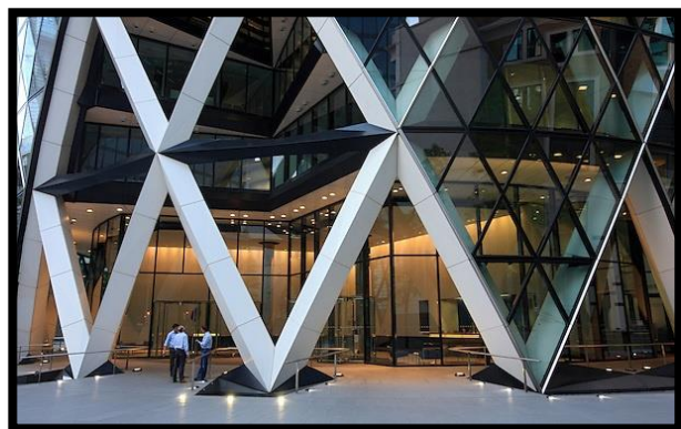
Figure 20 Hall d'entrée Source brunoperousse.photoshelter.com
