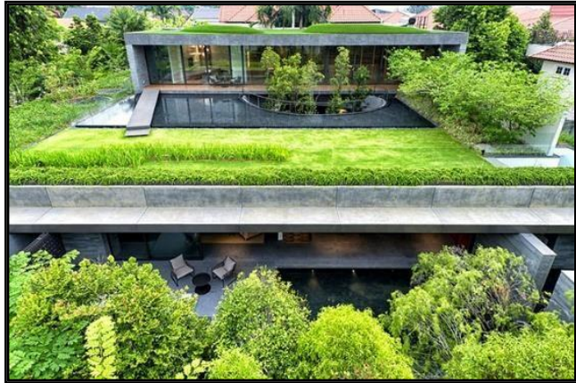
Figure 7: Toit terrasse Source : https://moncouvreur.pro
