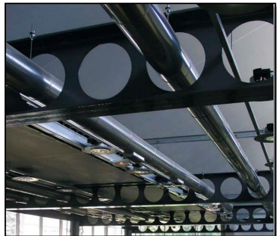
Figure 14 Poutres alvéolaires Source : http://www.archiexpo.fr/
