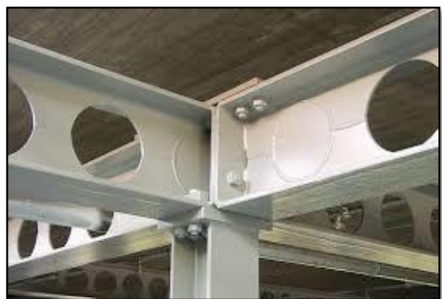
Figure 15 : assemblage poteau poutre métallique Source : www.archiexpo.fr/
