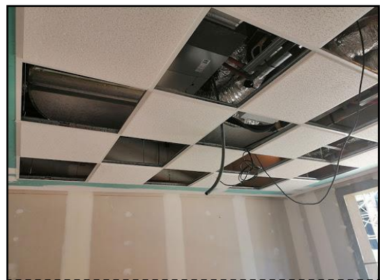
Figure 29 Mise en œuvre des faux plafonds Source faux-plafond.net
