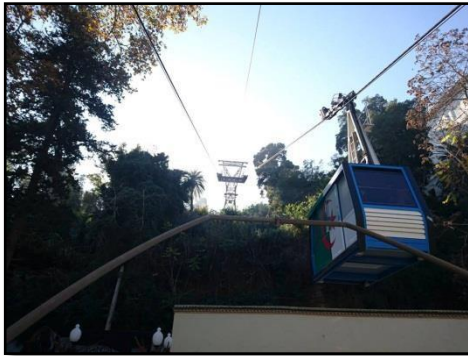
Figure 25 : Téléphérique Source : auteurs
