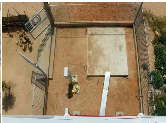
Figure II.10: Sécurisation du Site.
