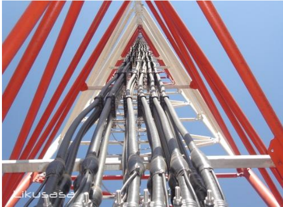
Figure II.11: Installation des feeders. l'équipement.
