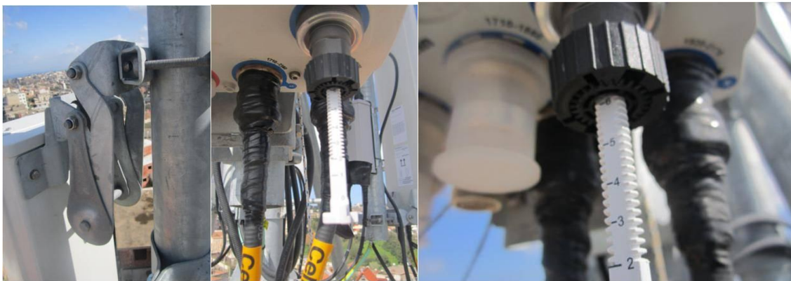
Figure II.13: Installation des antennes et réglage des Tilts mécaniques et électriques.
