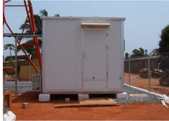
Figure II.12: Installation du Shelter et de l'équipement.
