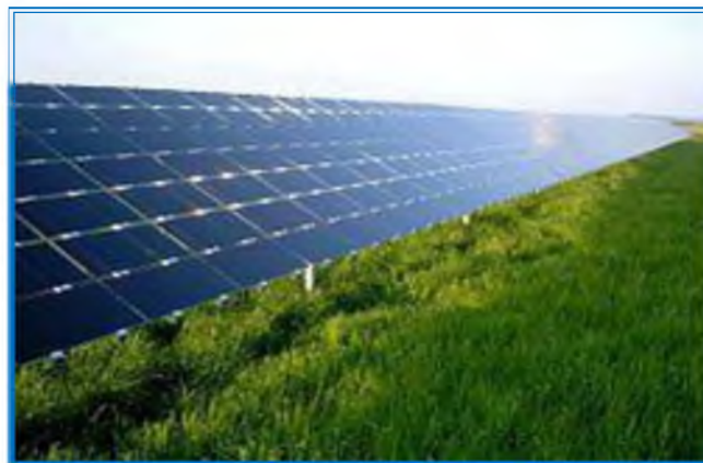
Figure 2.12. Panneau photovoltaïque en tellure de cadmium.
