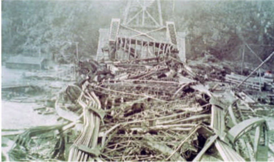
Figurel-3 : L'effondrement du pont du Québec 1907 [11]
