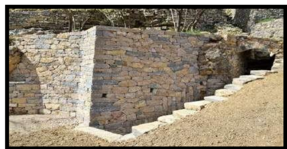
Figure 156: Mur de pierre en maçonnerie de moellon source auteur
