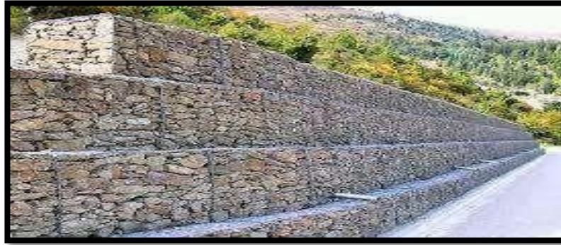
Figure 145: Mur de soutènement en gabionnage de pierre. Source Google
