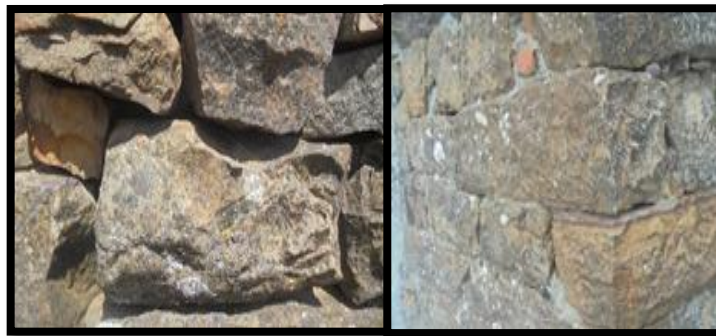
Figure 16:: Pierre utilisée dans la construction de la maison traditionnel Kabyle
