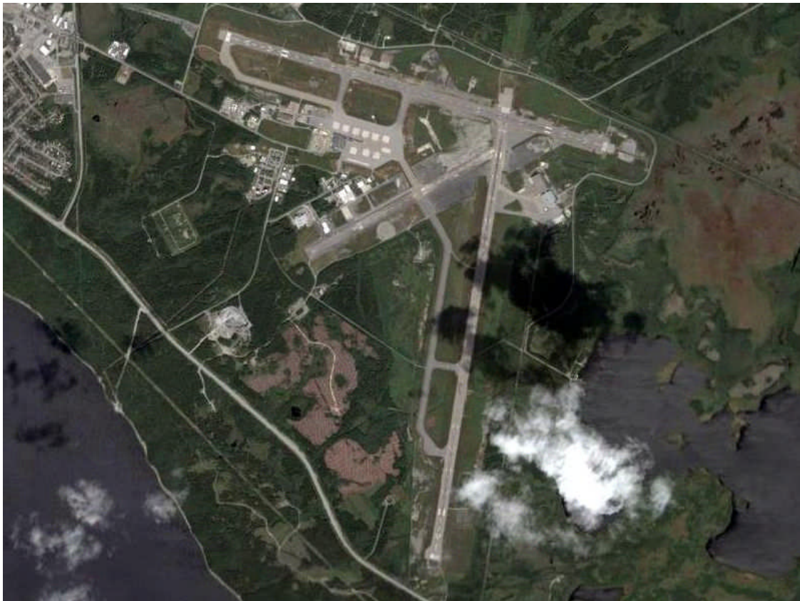
Figure I.1 : Vue aérienne d'un aéroport.
