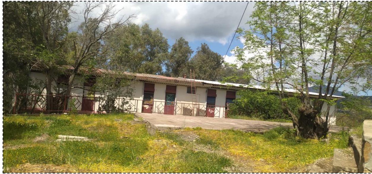
Photo 9: façade sud du bâtiment 14
