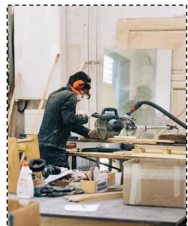
Figure 50: image montrant une zone de travail ;avec machines
