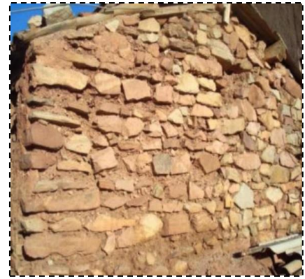
photo 47 : façade en pierre
