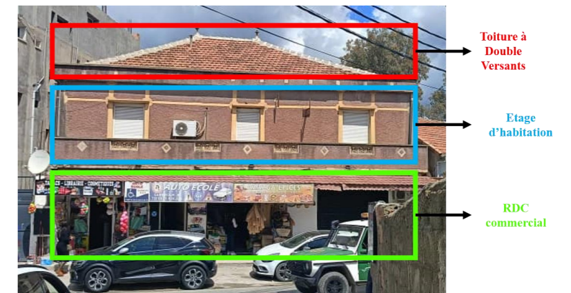
Figure 27: habitation coloniale au centre-ville d'azazga
