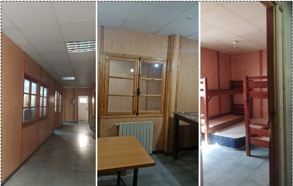
photo 30: l'intérieurs des chambres (bloc B)
