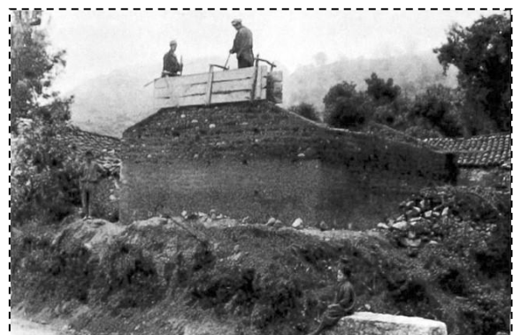
photo 49: Village d'Ait-Larbaa : construction d'une maison en pisé banché.
