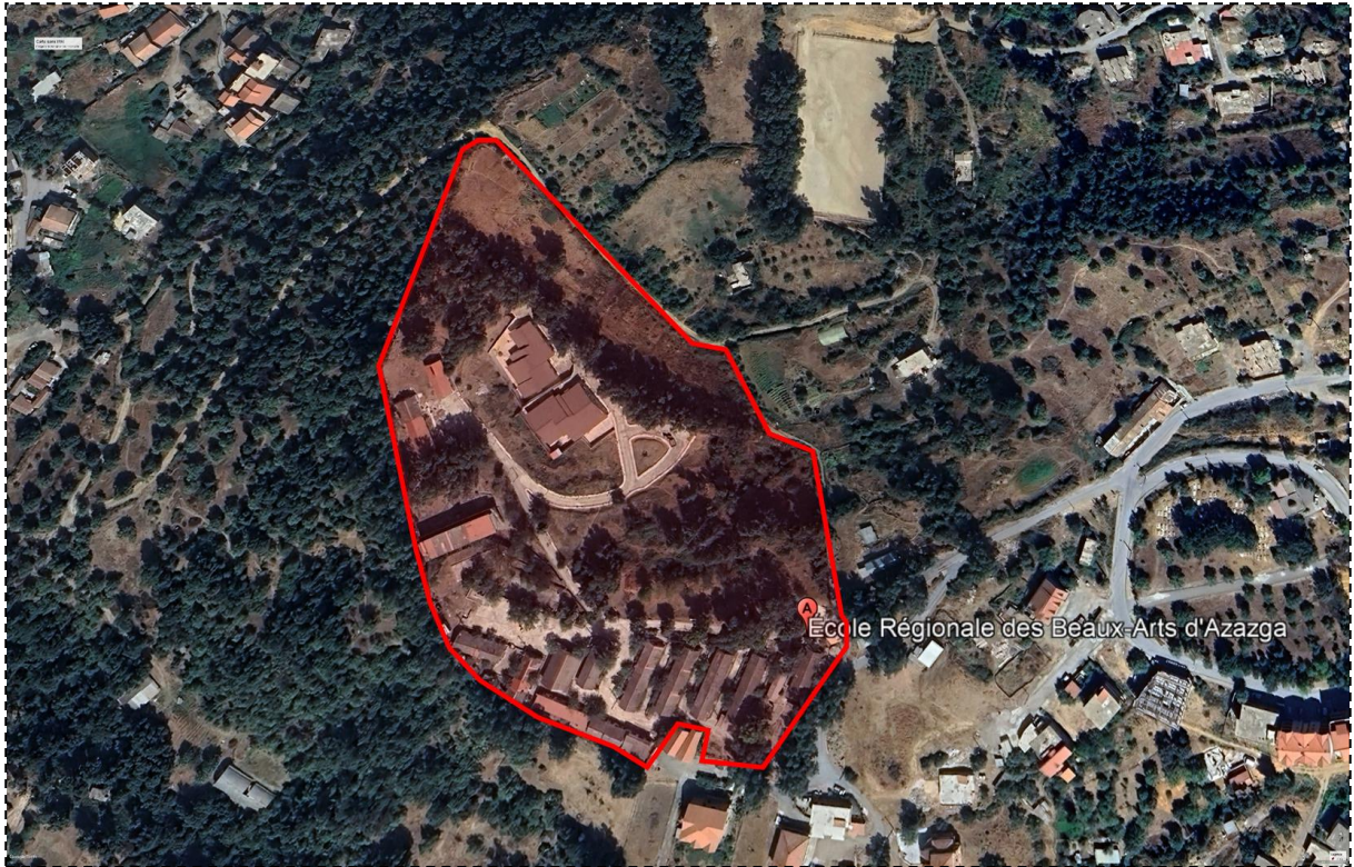
Figure 19: image aérienne de l'ERBAA dans son environnement immédiat
