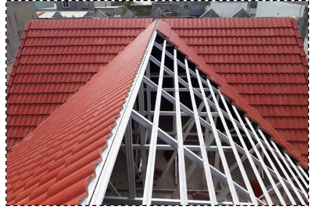
Figure 78: Pose de liteaux sur pannes métalliques
