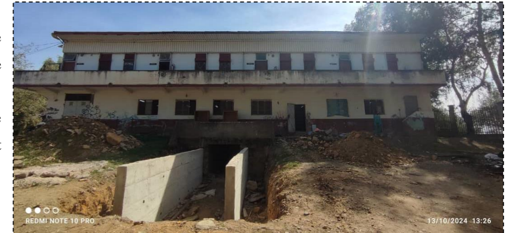
Photo 10: façade nord du bâtiment 14
