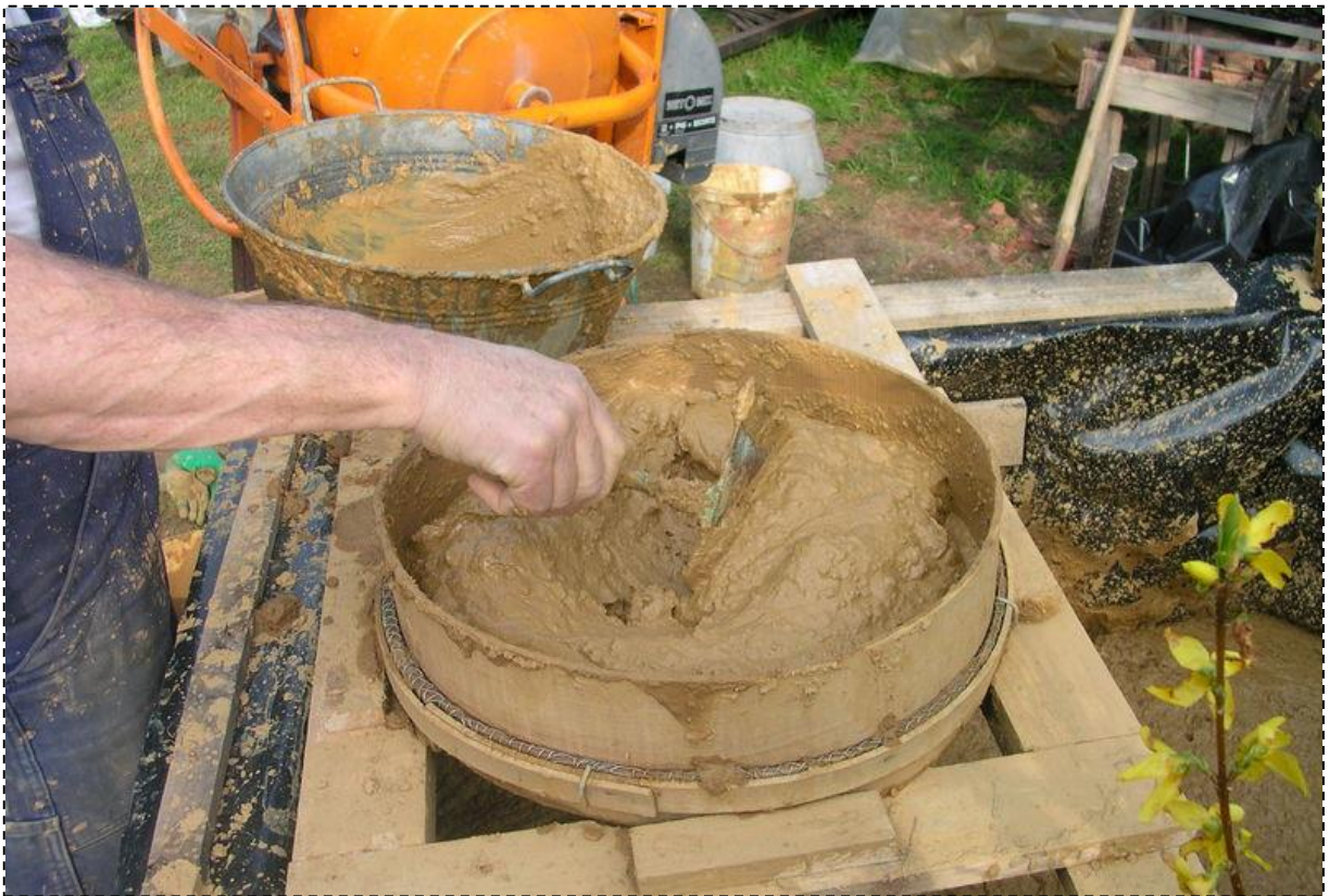
photo 81: photo montrant la preparation de l'argile
