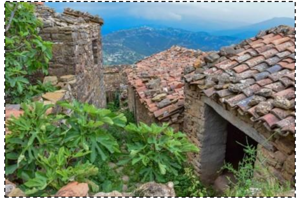
photo 50: toiture en tuile
