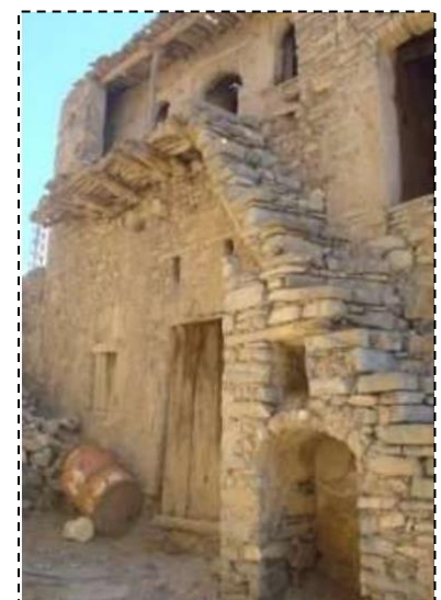
photo 43: escalier extérieur droit
