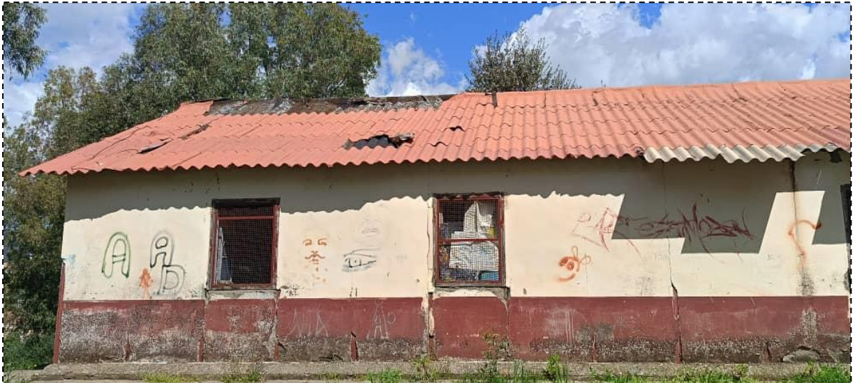
photo 8 : l'état extérieur du chalet 16
