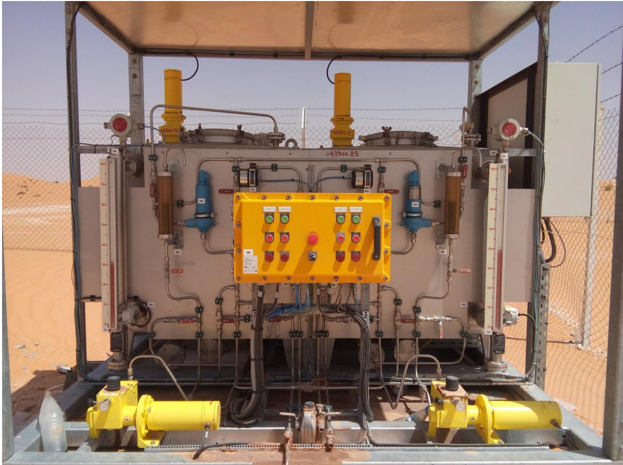
Figure 2.2. Le SKID d'injection produit chimique
