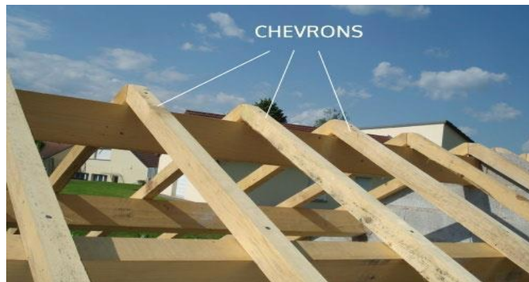
Figure I.1 .5 : la mise en œuvre des chevrons
