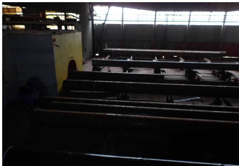
Figure II.8 : sortie de la cabine RX
