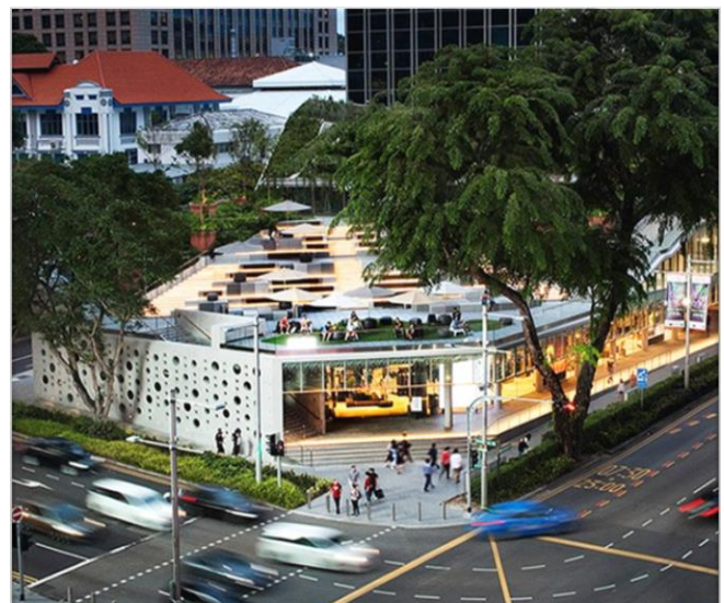
Figure 98 : Vue depuis l'intersection des voies de Singapour
