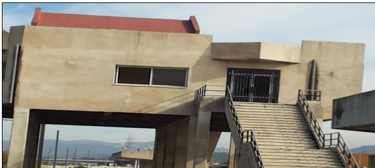
Figure N°07 : Image de la gare Oued-Aissi
