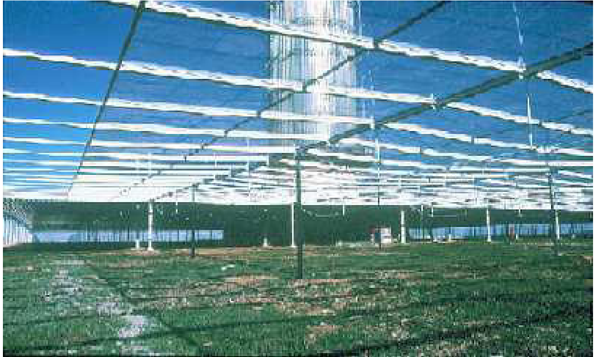
Figure I.3 : Vue interne du collecteur d'une cheminée solaire.
