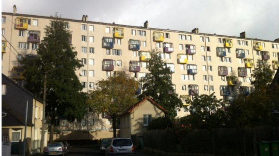
Figure 12: cité le grand bleu. Architecte Georges Maillol, Rennes, France, 1958.
