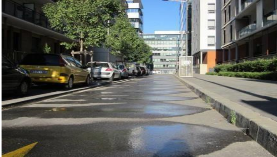
Figure 31: humidification de chaussée, Rue de la Buire, Lyon (Projet Véolia).
