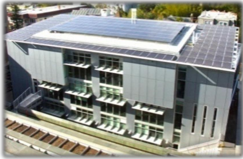
Figure 69: les panneaux photovoltaïques sur la façade Sud.
