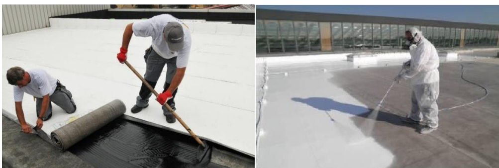
Figure 123: mise en œuvre de toiture réfléchissante.
