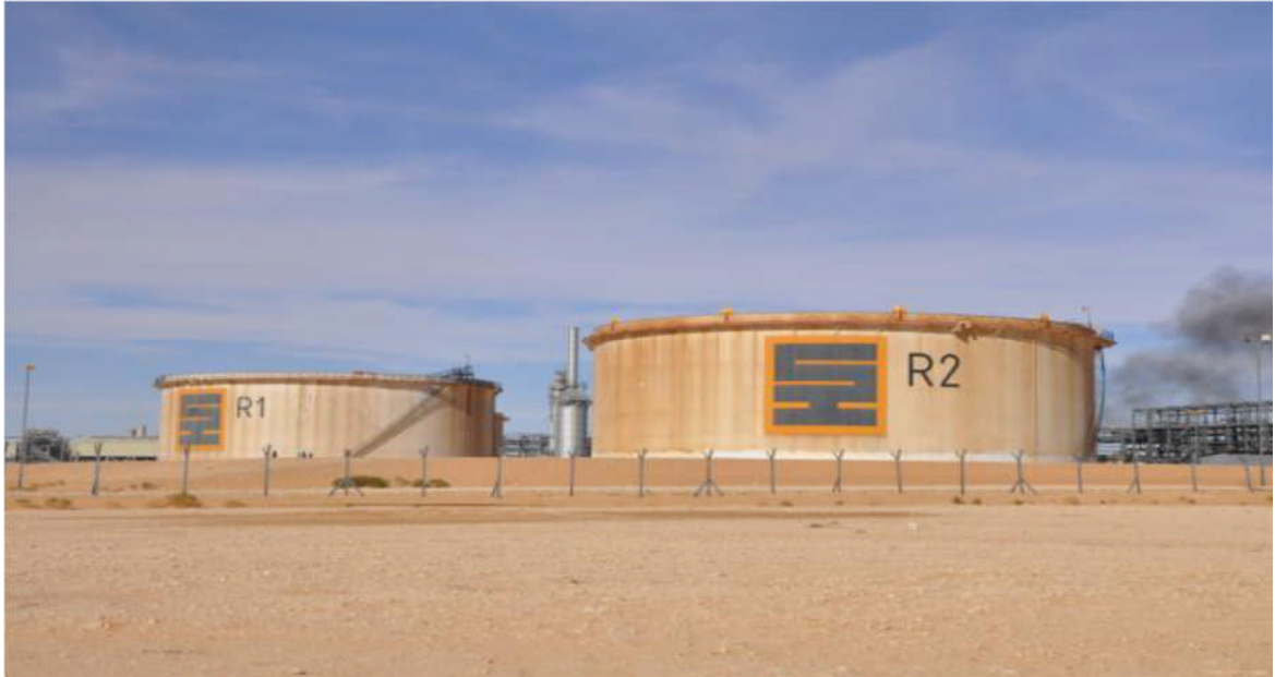
Figure I.5 : Bac à toit fixe gasoil
