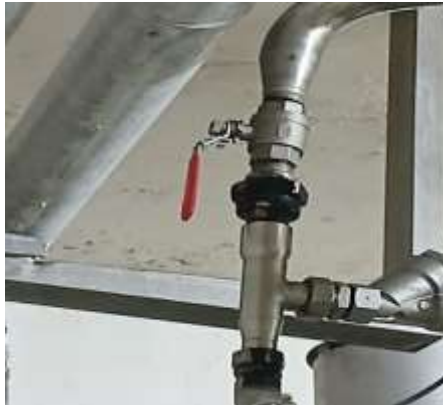
Figure I.26 : Alimentation générale eau froide.
