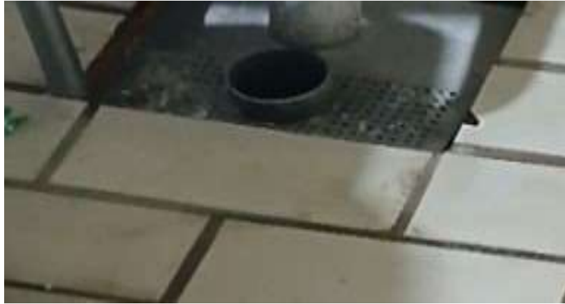
Figure I.29 : Sortie égout général
