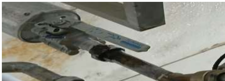
Figure I.28 : Alimentation vapeur (pression 4 bars).
