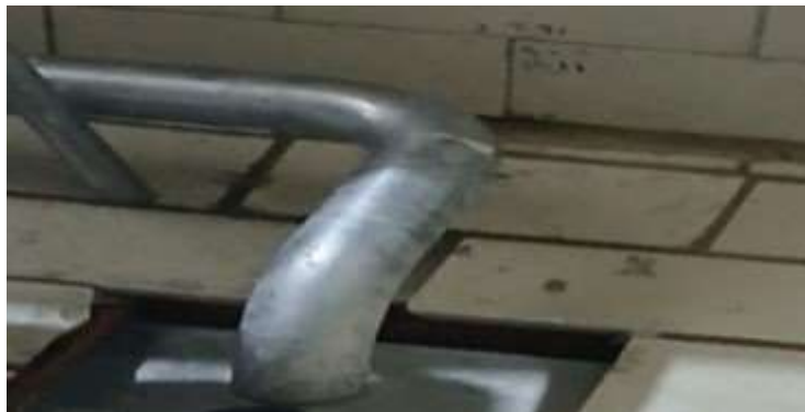
Figure I.27 : Sortie condensats.
