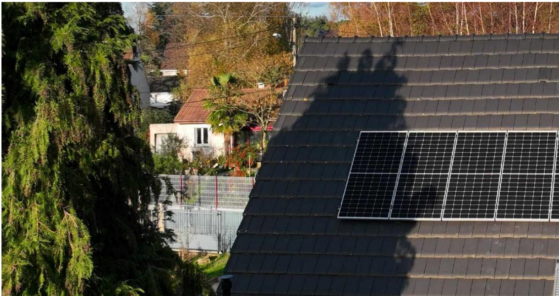
Figure II-1 : Système photovoltaïque pareillement ombré [11].
