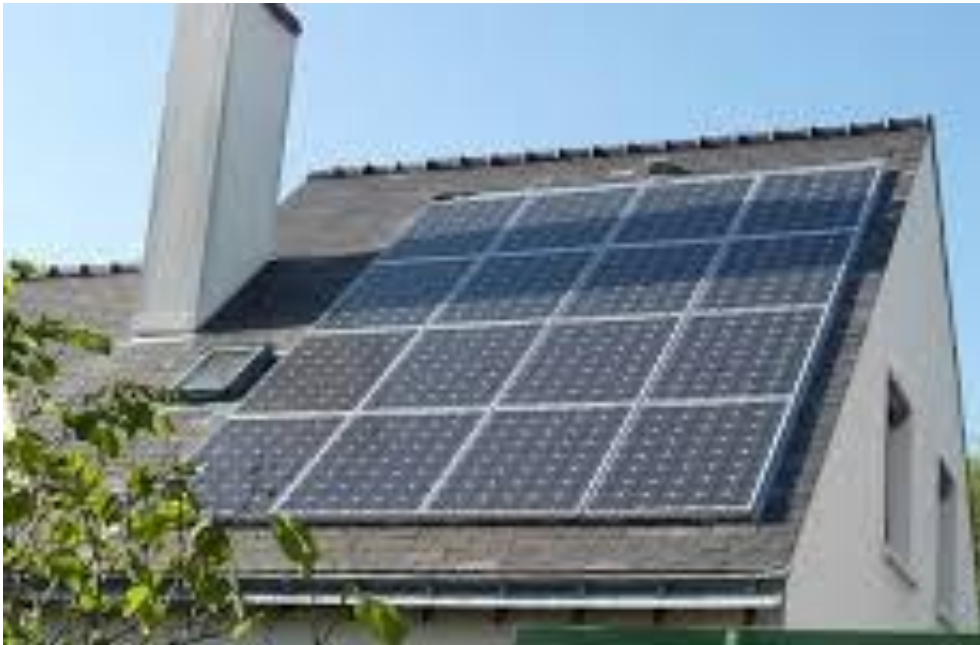
Figure II-2 : Exemple ombrage direct sur un panneau PV [11].
