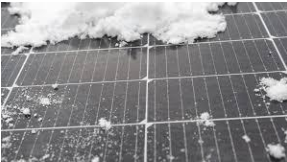
Figure II-3 : Exemple d'ombrage temporaire [11].
