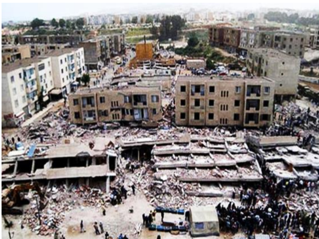
Figure I.1 : Le séisme de Boumerdès 2003.
