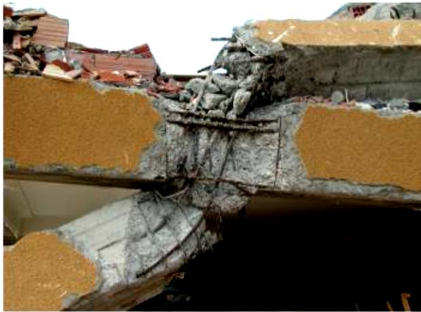
Figure I.3 : Rupture en zone nodale [1]. Figure I.4 : Dislocation de la section [1].
