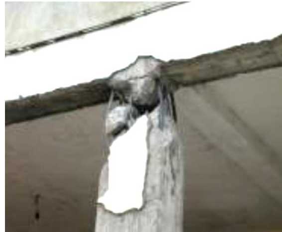
Figure I.3 : Rupture en zone nodale [1]. Figure I.4 : Dislocation de la section [1].
