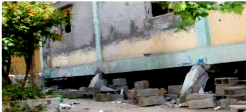
Figure I.5 : Poteaux courts dus au vide sanitaire [1].
