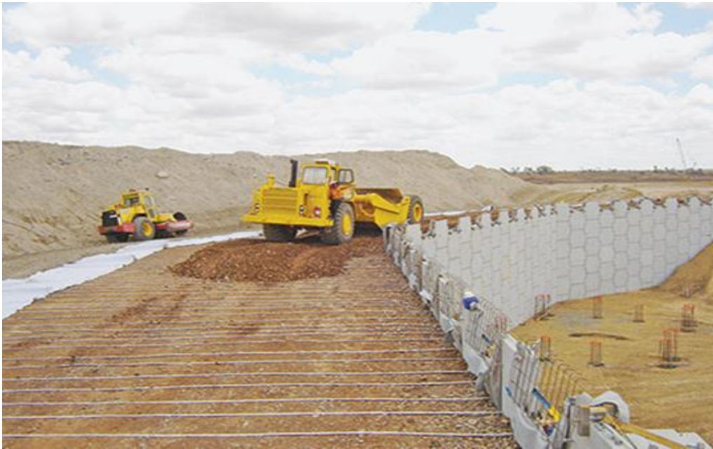
Figure 1- 26 : Chantier de montage de murs en sol renforcé (Terre Armée)
