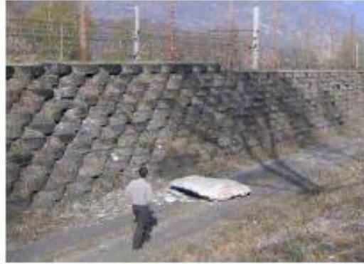
Figure 1- 12 : Parement en Pneusol
