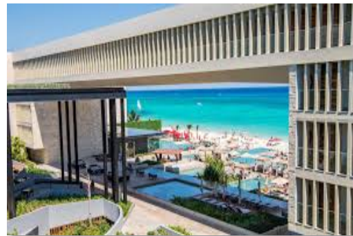
Figure 30: brise-soleil extérieurs, fixes ou mobiles
