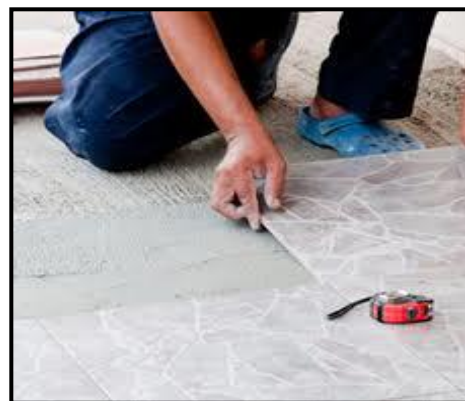
Photo IV.08 : Carreaux de marbre
