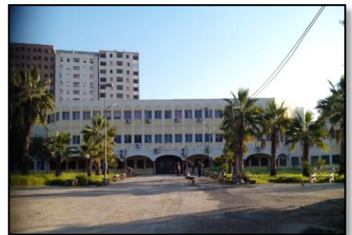
Photo II.14 : bloc administratif de l'ex CBM Source : Auteurs
