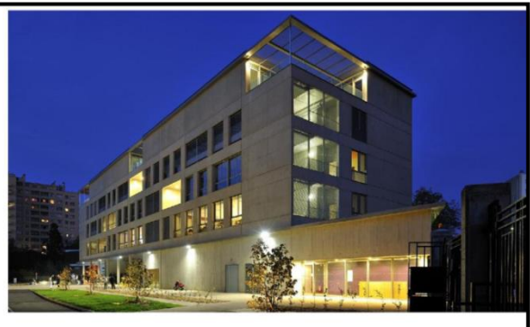
Photo II.07: L'éclairage extérieur illumine
