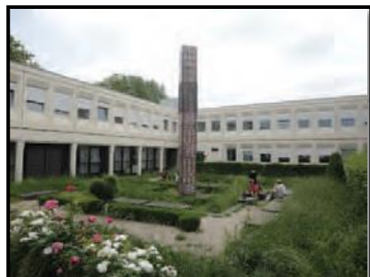
Photo I.07 : Les patios Source : Google earth 2010
