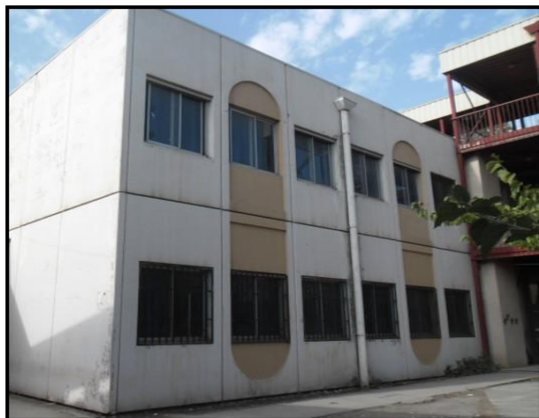
Photo II.15 : Façades d'un bloc de l'ex CBM composé de panneaux en béton préfabriqué. Source : Auteurs
