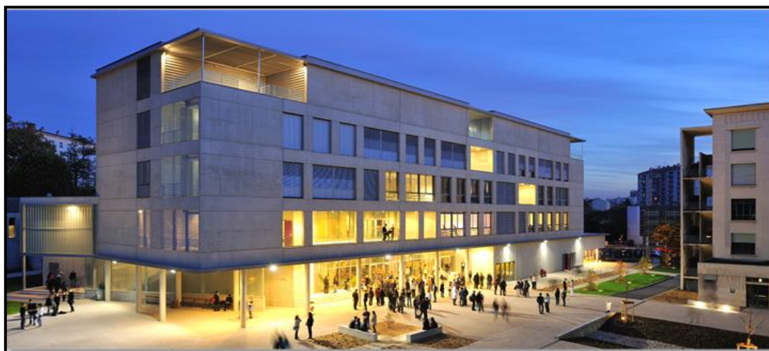
Photo II.01: Le nouveau bâtiment Jean-François CIER Source : http://vurpas-architectes.com/
