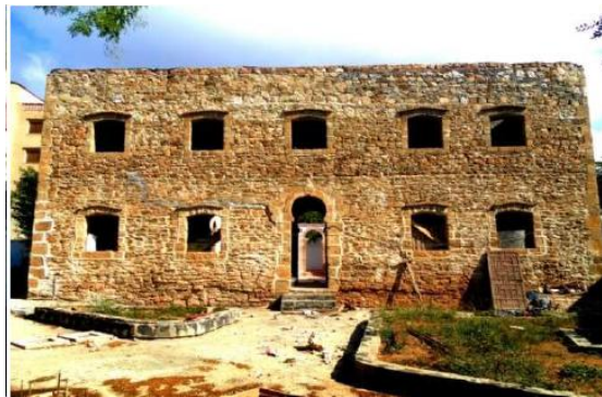
Figure III.16 : la maison des Ait Kaci après sa restauration
