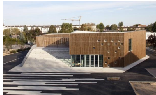
Figure V.4 : façade principale Source : www.batiweb.com .
