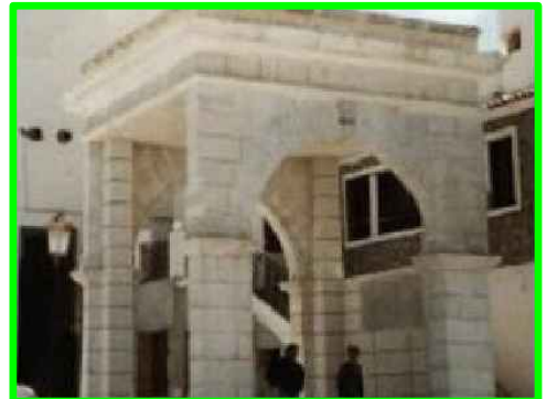
L'édification d'une porte monumentale à l'entrée de la ville (au rend point Djurdjura) à coté de l'ex porte de Bougie.
