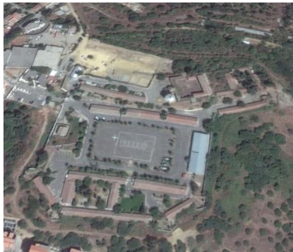
Figure III.12 : Vue aérienne du bordj turc
