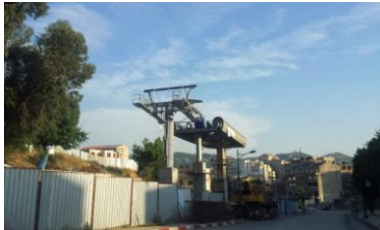
Figure IV.14 : Station téléphérique. Source : www.elwatan.com .
