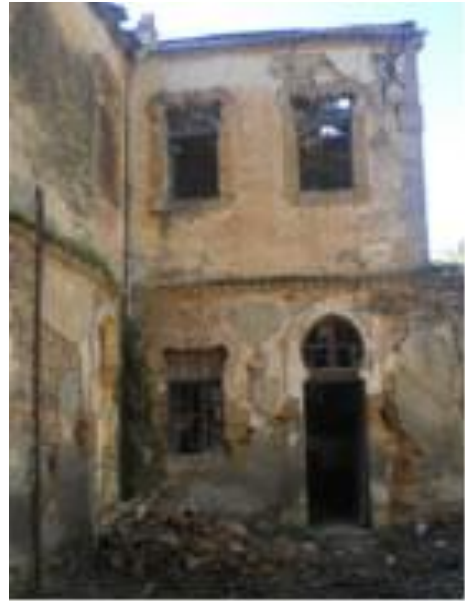
Figure III.15 : la maison des Ait Kaci avant sa restauration
