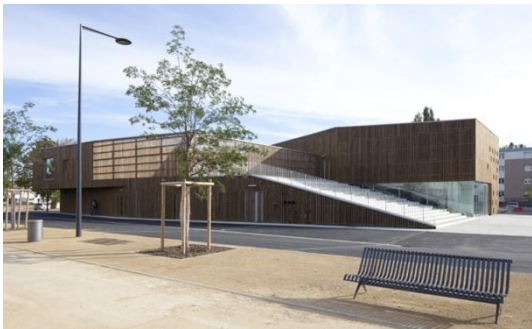
Figure V.3 : espace extérieur du centre Source : www.batiweb.com .
