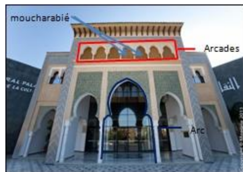
Figure V.12 : façade principale du palais. Source : palais-culture-tlemcen.org
