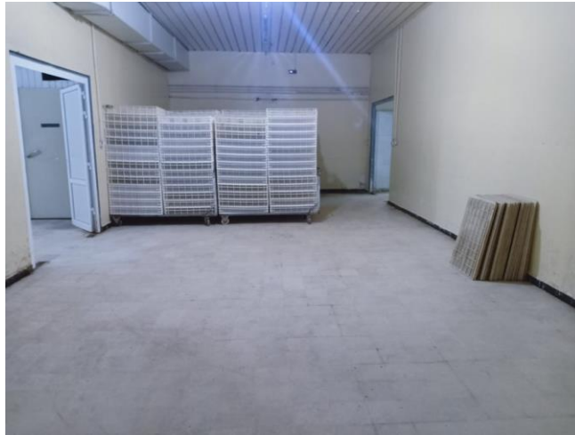
Figure 3.48 : Salle de transfert.
