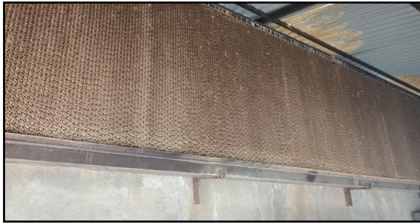
Figure 3.20: Système d'humidification pad -cooling (Photo personnelle).
