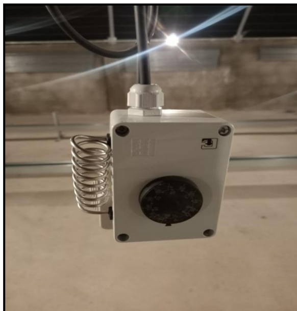
Figure 3.33: Sonde et thermostat de propène. (Photo personnelle).
