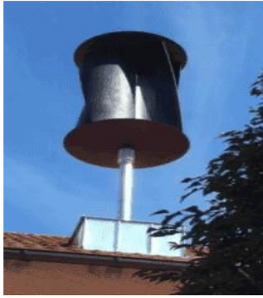
Figure II. 5: Eolienne à axe vertical (structure de Savonius) [48]
