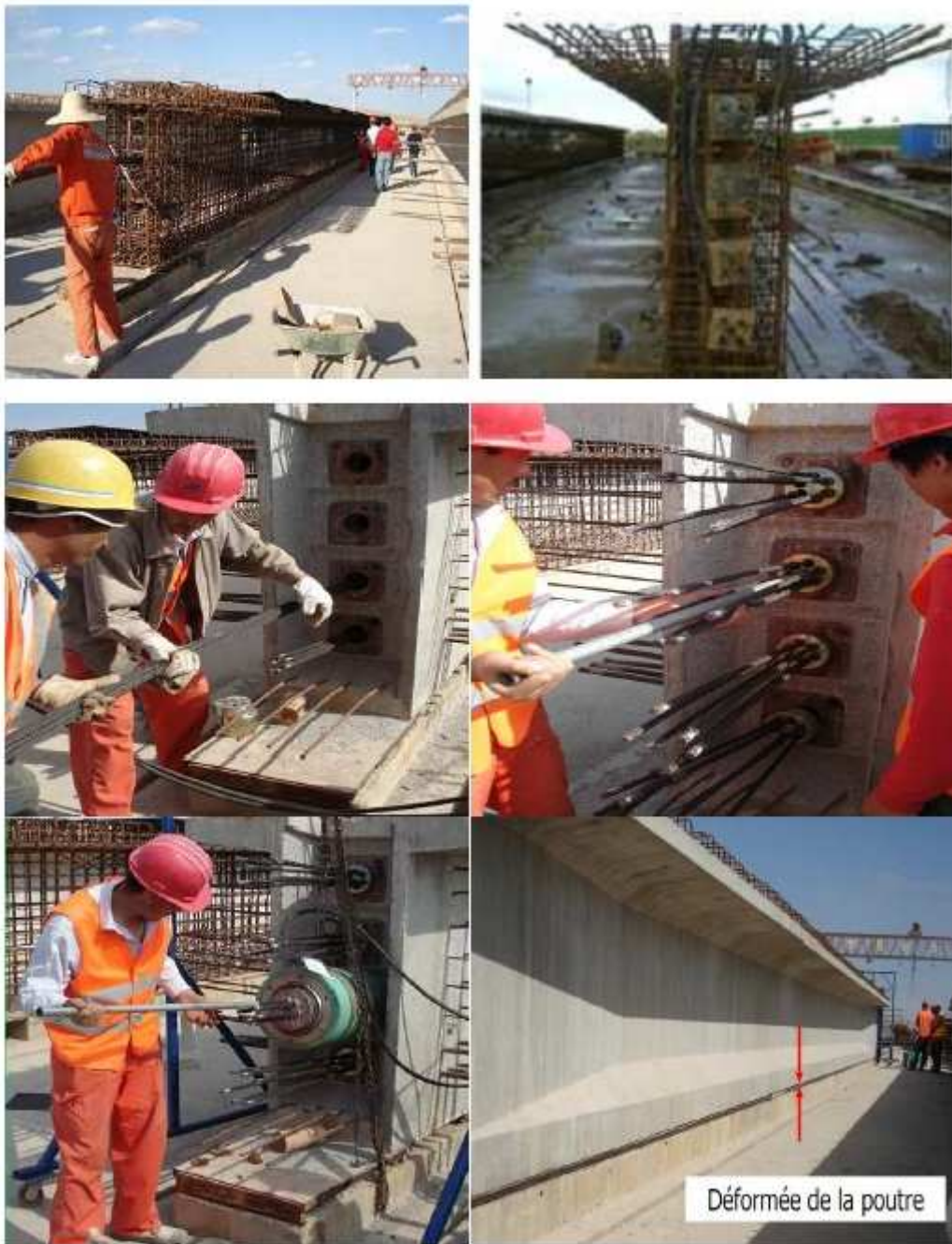
Figure IX-6: photos montrant les différentes étapes de fabrication d'une poutre en béton précontraint
