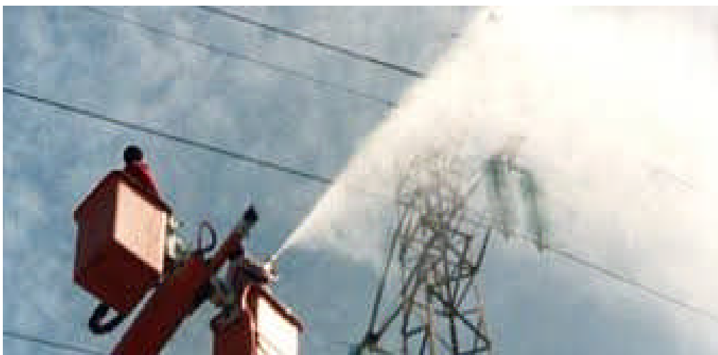
Figure II.2 Lavage sous tension d'un isolateur
