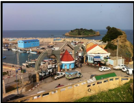
Photo II.31 : l'entrée du port de pêche Source : auteurs
