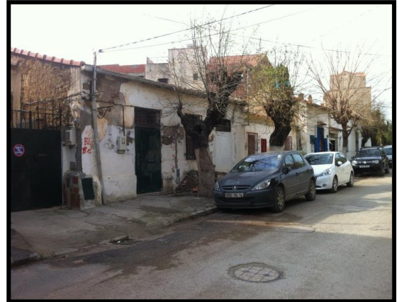
Photo II.12 : l'état des bâtis coloniaux à Tizirt Source : Auteurs
