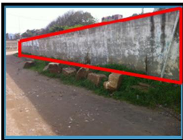
Photo II.4 : type de mur de clôture des ruines Source : Auteurs
