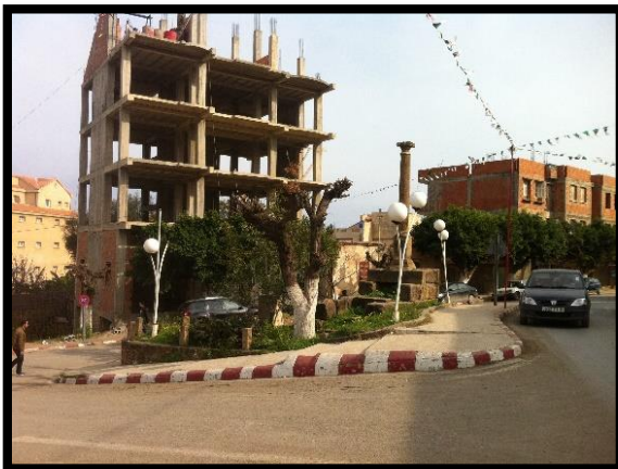
Photo III.38 : Nœud de la daïra avant intervention Source : Auteurs
