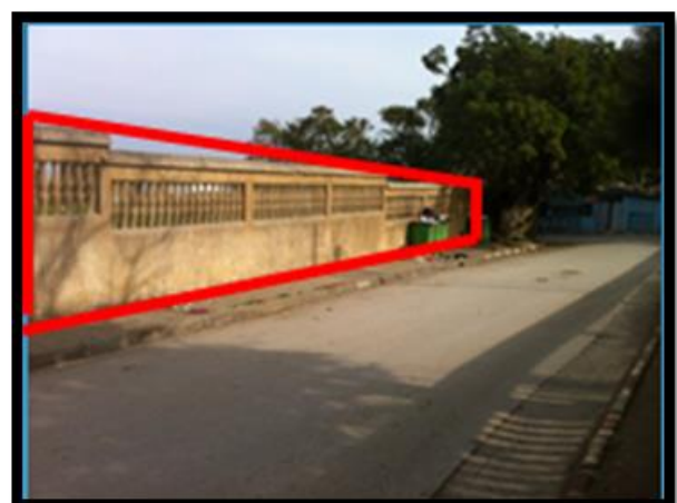
Photo II.5 : type de mur de clôture des ruines Source : Auteurs
