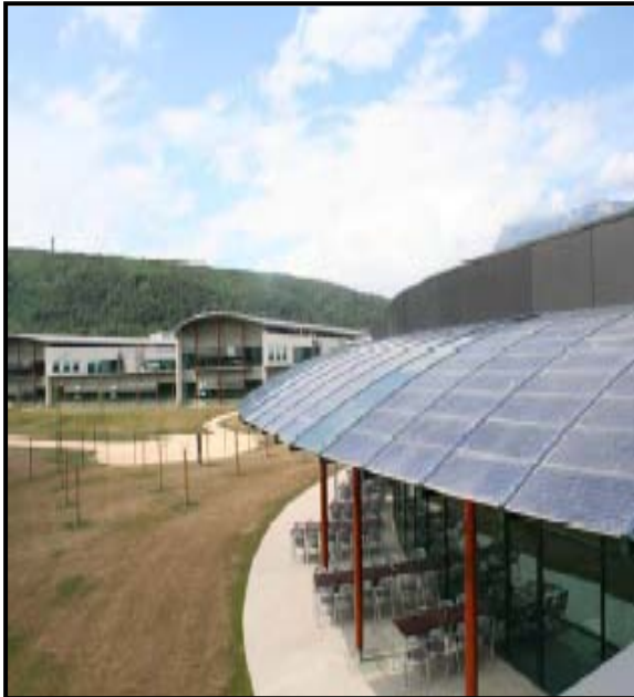
Photo 4.3 : Intégration des panneaux photovoltaïques dans l'architecture [146].
