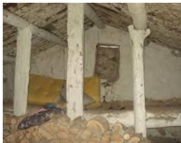
Figure 25 : Vue Taaricht maison kabyle Source : Maison Kabyle - A l'intérieur de Tazekka (2019)
