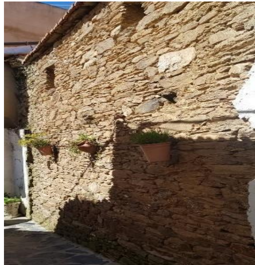
Figure 27 : Vue de mur en pierre lié avec un mortier (Tiferdoud)
