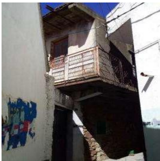
Figure 50 : Superposition de construction nouvelle sur un soubassement en pierre.
