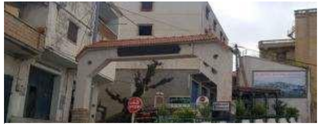
Figure 54 : Entrée principale au village de Tiferdoud Source : auteurs (18/03/2021)
