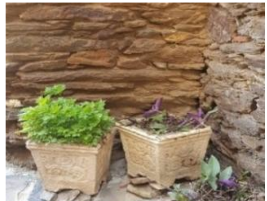
Figure 29 : mur en pierre(Tiferdoud) source : auteurs (18/03/2021)
