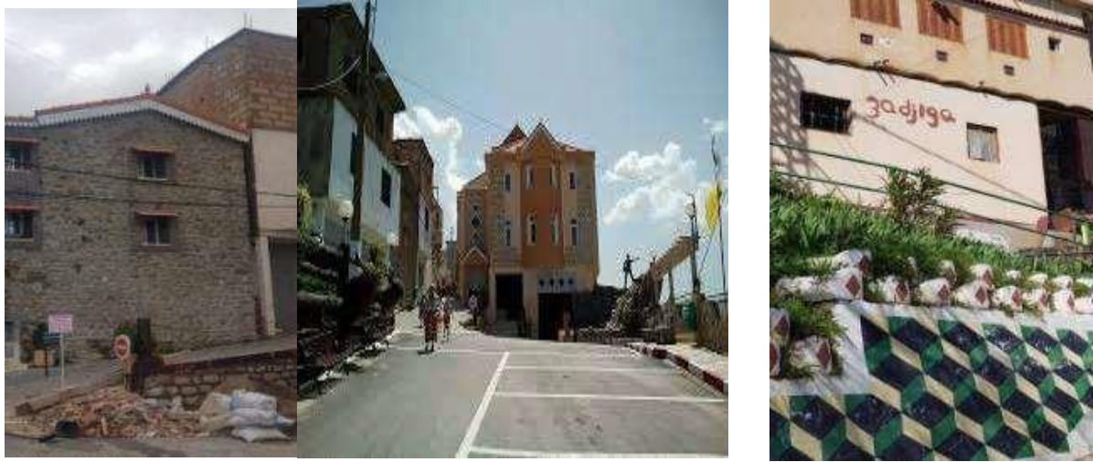
Figure 52 : des nouvelles constructions au village de Tiferdoud
