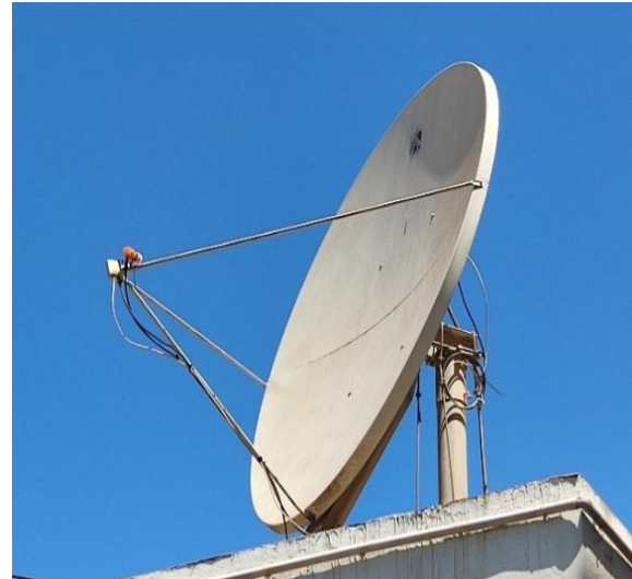
Figure 49: Antenne parabolique orientée vers le satellite SES4 22°W.
