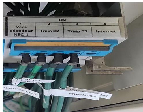
Figure 46: Les quatre trains de 34 Mb/s reçus à travers la liaison FH.
