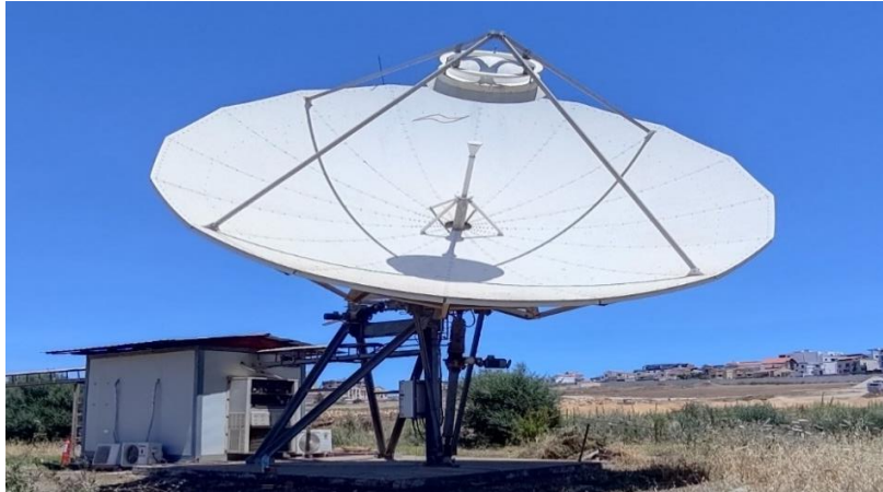
Figure 67 : Antenne parabolique de 7.6 m de diamètre, orientée vers le satellite SES4.
