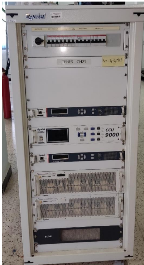
Figure 58: Emetteur TNT EGATEL de la série TE9301 600W DD.
