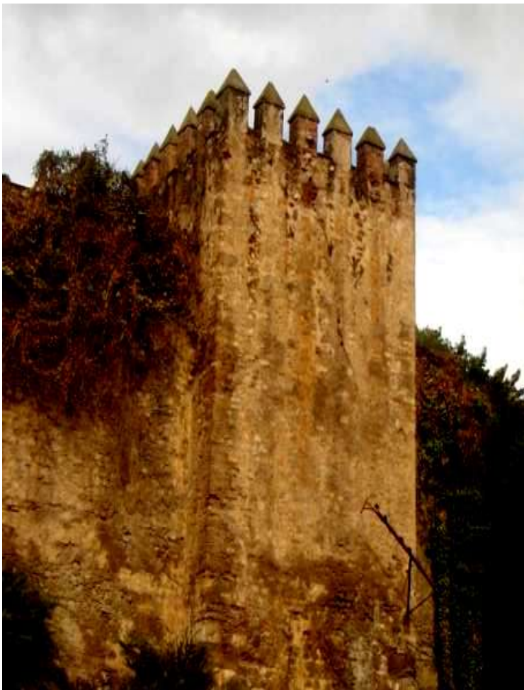
Photo 19.5 : La batterie Arsêmes.
