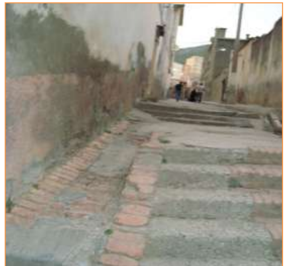
Photo 7.6 : Revêtement d'une ruelle.
