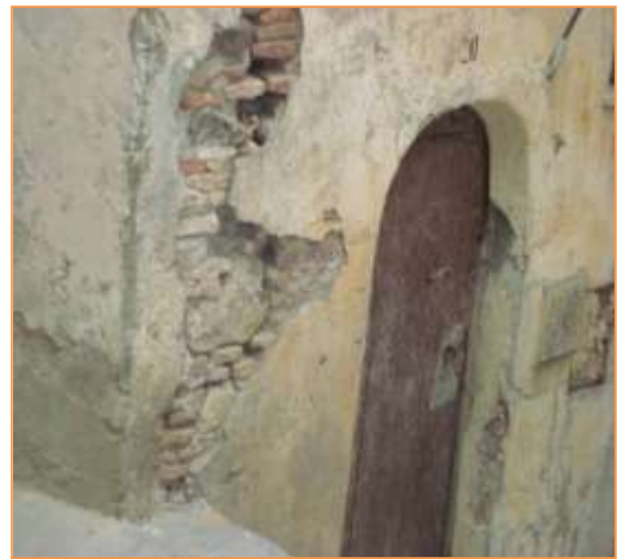
Photos 5.6 : Mur porteur lézardé et détail décoratif en tuile et brique de terre cuite.
