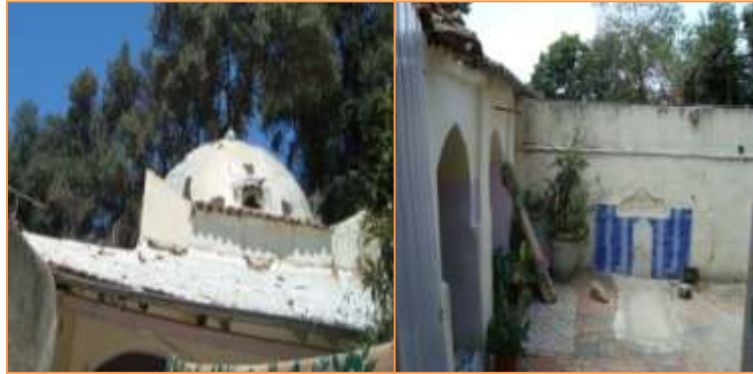
Photos 10.7 : Vue sur la coupole et les chambres.
