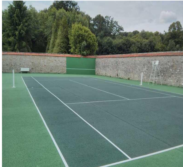
Figure I. 12: Stade de tennis en béton drainant .
