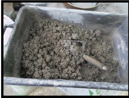
Figure II.6. Gachée du mortier
