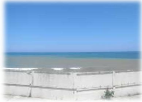
Figure 11: La clôture côté mer
