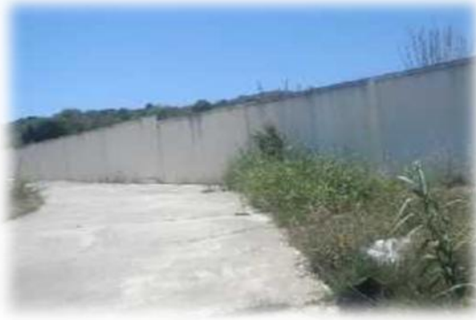
Figure 10: La clôture côté terre
