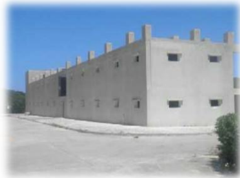
Figure 13 : Bâtiment de l'écloserie
