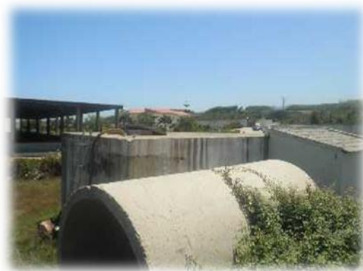
Figure 17 : Les deux forages sur site à terre
