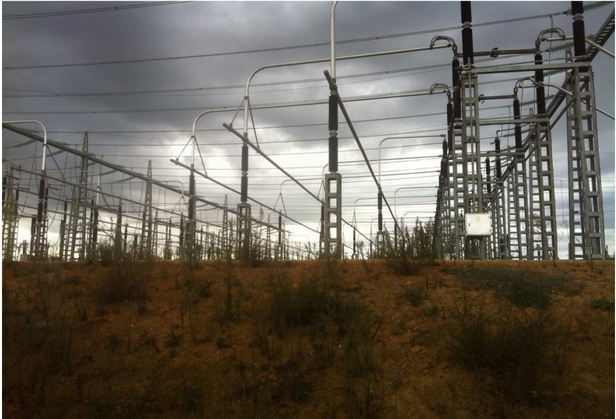
Figure I.15 : Jeux de barres
