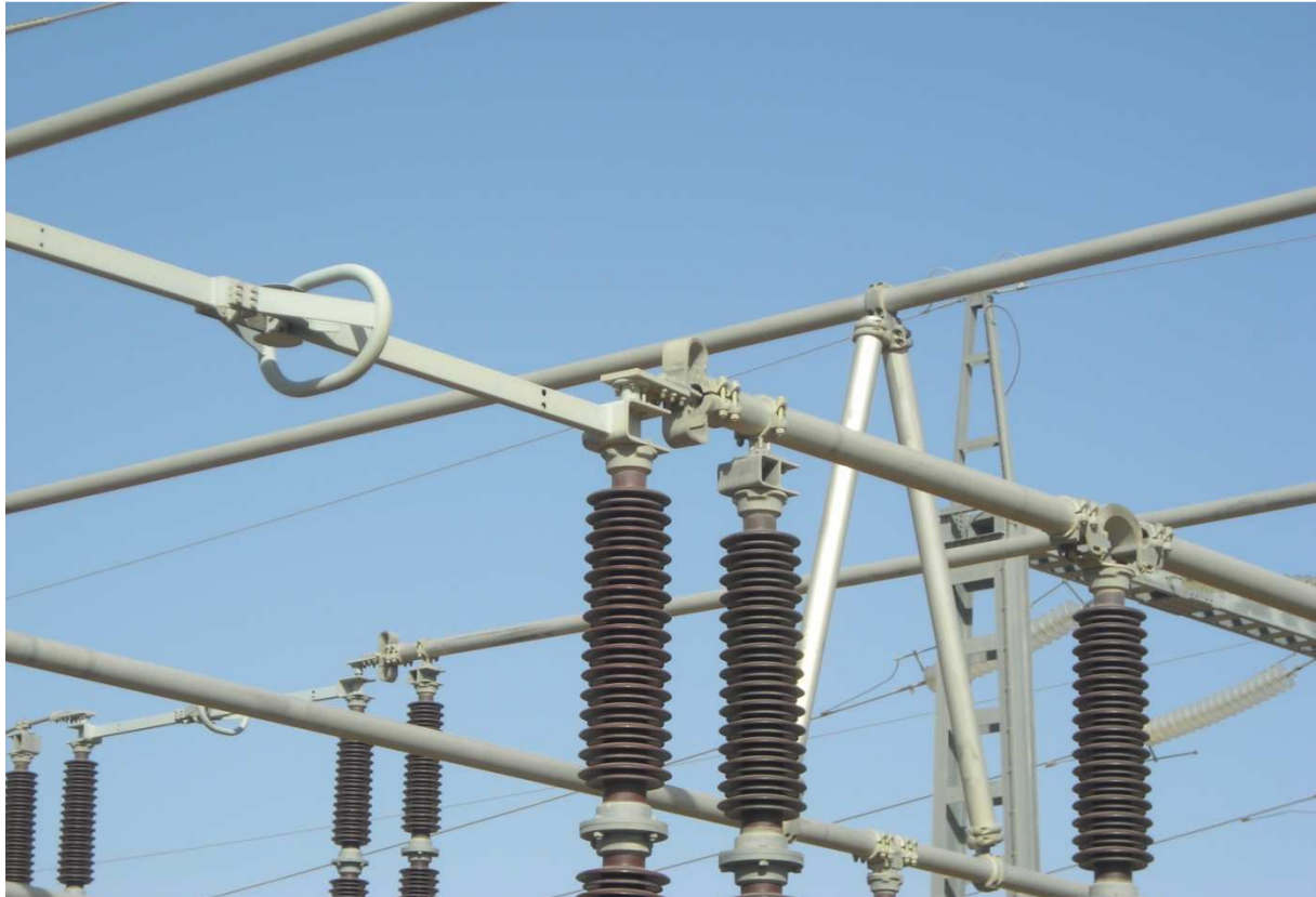
Figure I.13 : Sectionneur de barre
