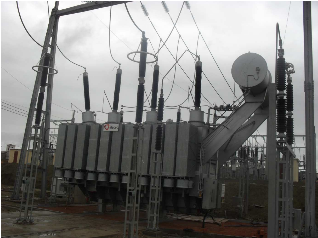
Figure I.8 : Transformateur de puissance pour l'étage 220kV
