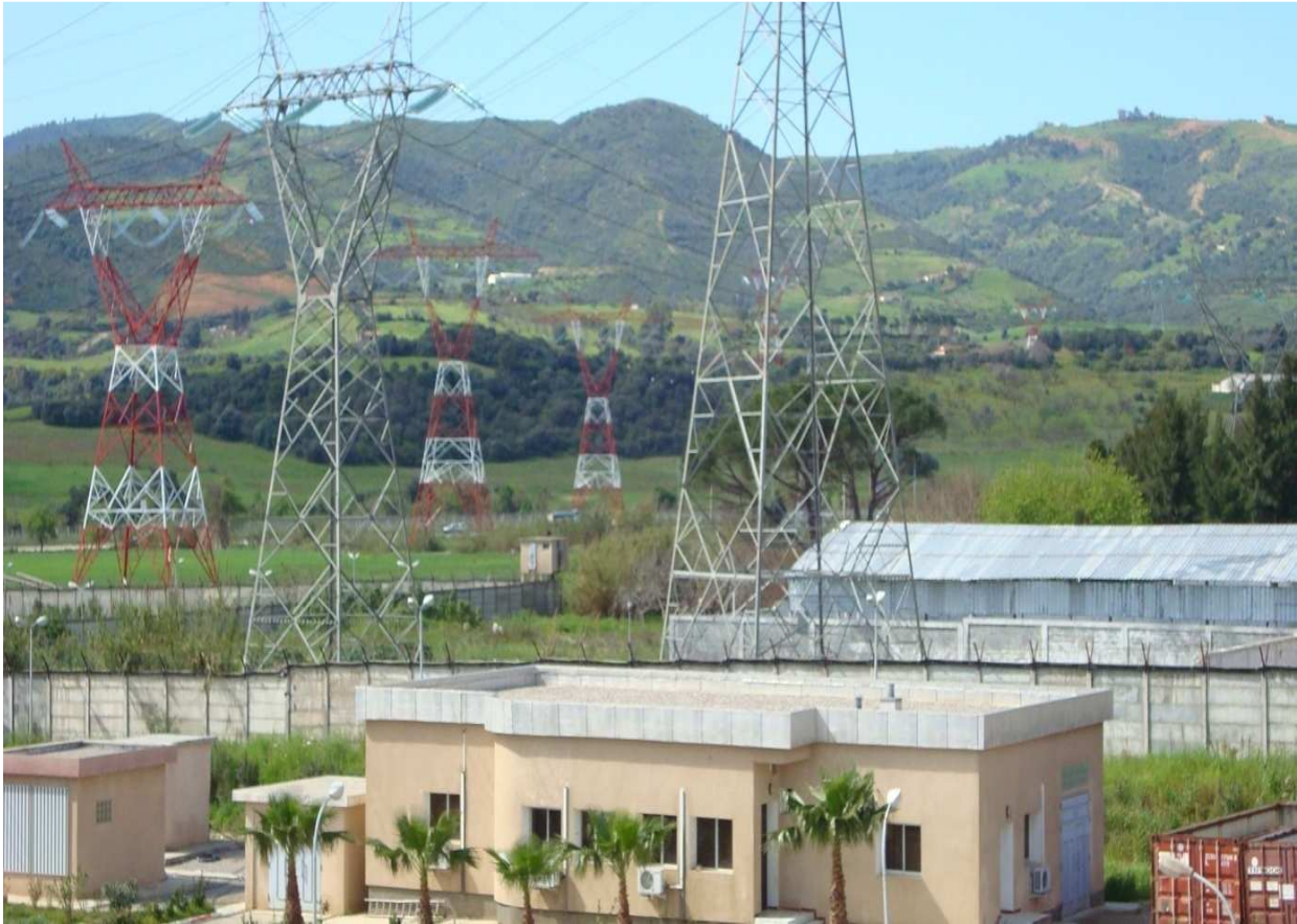
Figure I.6 : Partie intérieure du Poste
