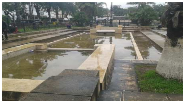
Figure58 : image sur la placette de Tripoli Source : image prise par l'auteur
