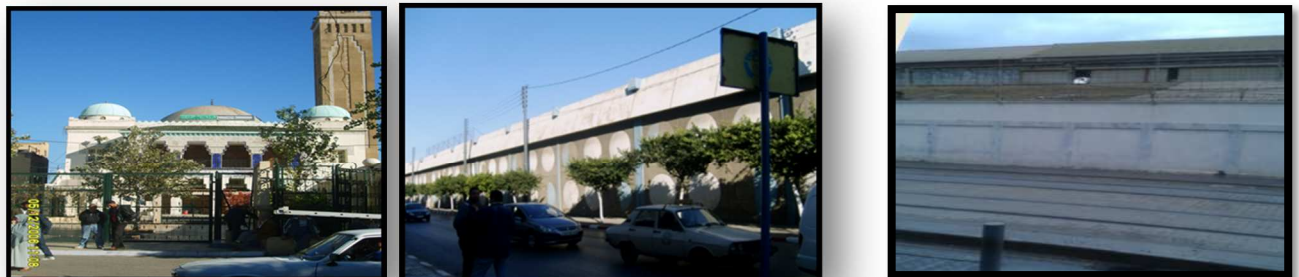
Figure 44 : images de façades donnant sur rue tripoli Source : images prises par Auteur Usine BATIMETAL
