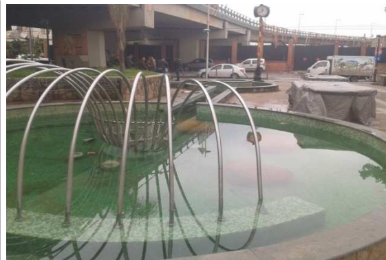
Figure49 : Le seuil matérialisé par la place sous pont Source : image prise par l'auteur
