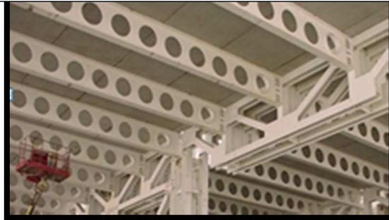
Figure142: detail des poutres alveolaires source : www.detailconstructif.cype.com
