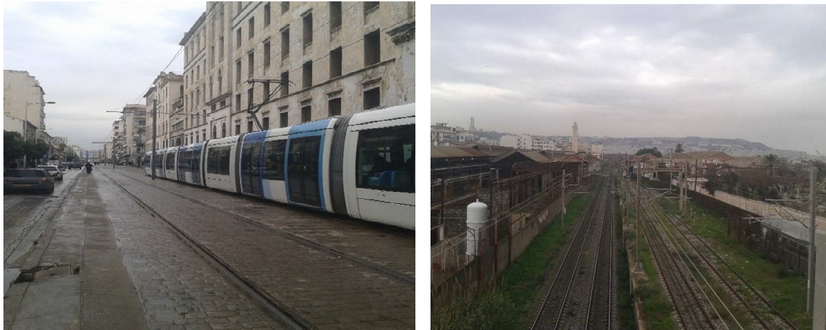
Figure 82 : Vue sur le chemin de fer et le tramway avant l'intervention
