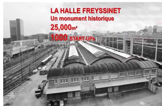
Figure 118 : La halle Freyssinet avant sa réhabilitation
