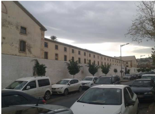
Figure 95 : Vue sur le lycée thaalibia avant l'intervention
