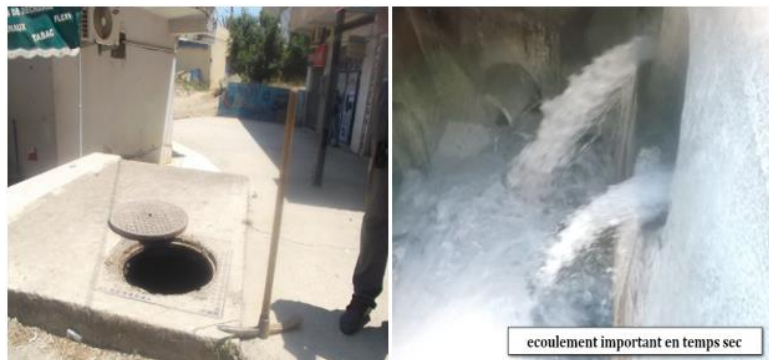
Figure II. 11 : regard sur le collecteur 2 x 700.
