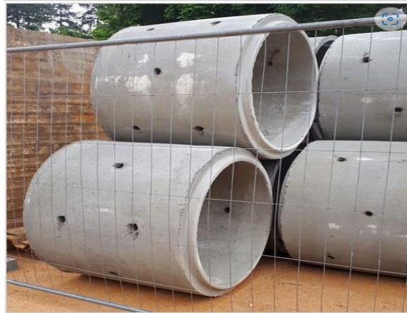
Figure VI. 3: Puits d'infiltration préfabriqués.
