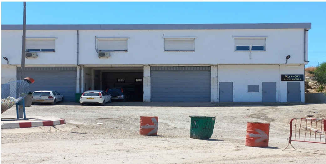
Figure N°12: Le bloc administratif
