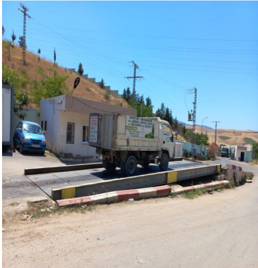
Figure N°06: Le pont bascule
