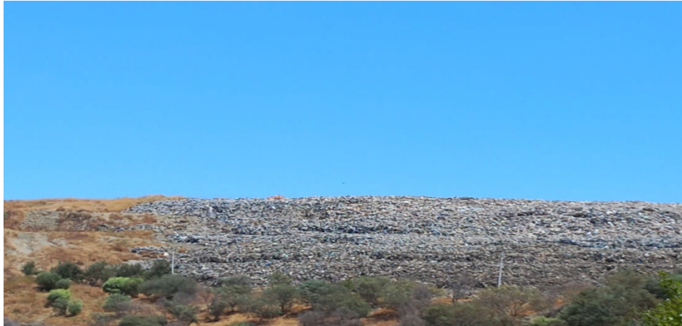
Figure N°21: Le 1 er casier en phase de fermeture
