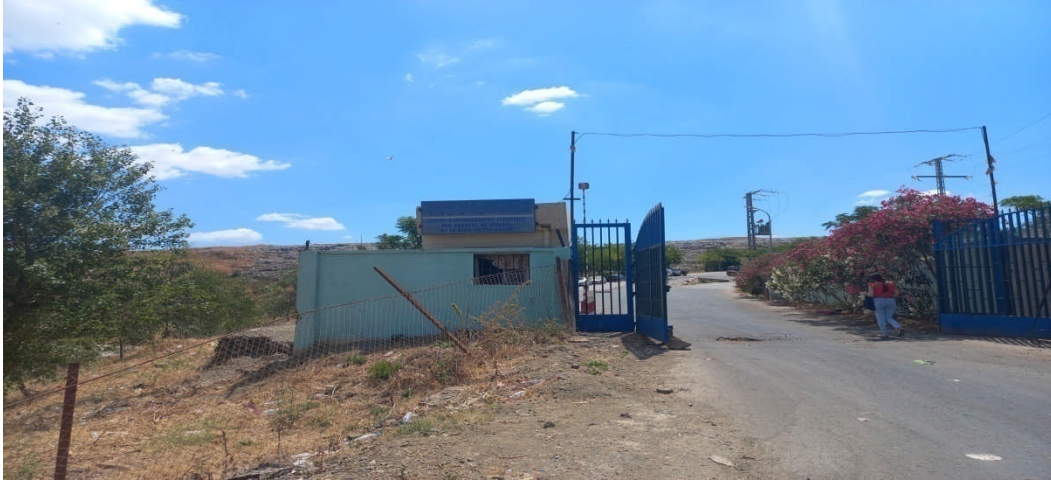
Figure N°04: Le portail d'entrée du CET d'Oued Falli
