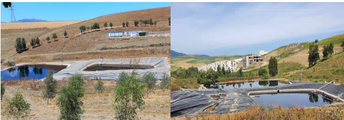
Figure N°22: Bassin de rétention du lixiviat
