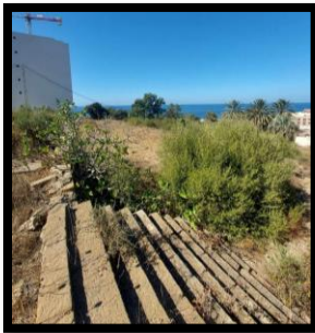
Figure 54-Photo d'escalier coté haut. Source : auteures.
